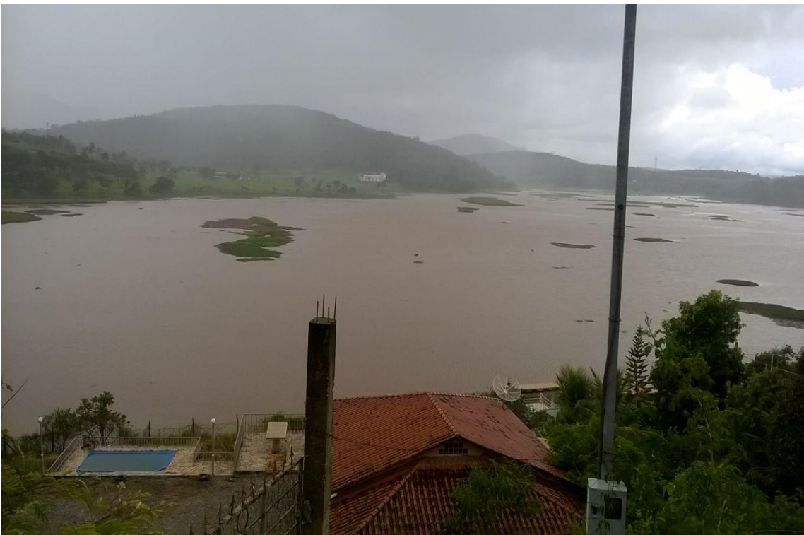
FOTO 18 - Espelho de água da PCH do Carioca é novamente avistado. Data: Jan. 2016.
