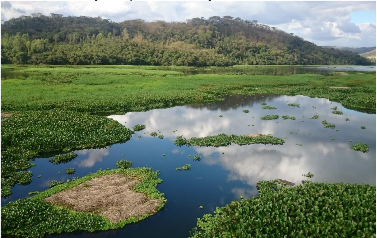
FOTO 26 - Vista representativa da atual situação da PCH do Carioca, massas de braquiárias vivas e algumas morrendo devido falta de contato de suas raízes com o solo e o início de uma nova proliferação de macrófitas aquáticas no reservatório.
