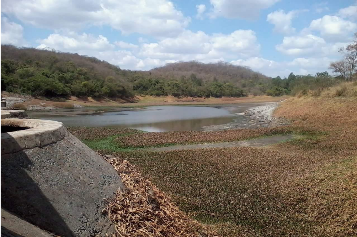
FOTO 13 - Vista para início do rebaixamento do nível de água do reservatório provocado pela crise hídrica e pela Santanense. Data: Set. 2015.
