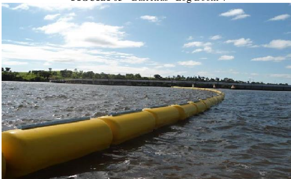
FIGURA 03 - Barreiras “Log Boom”.
