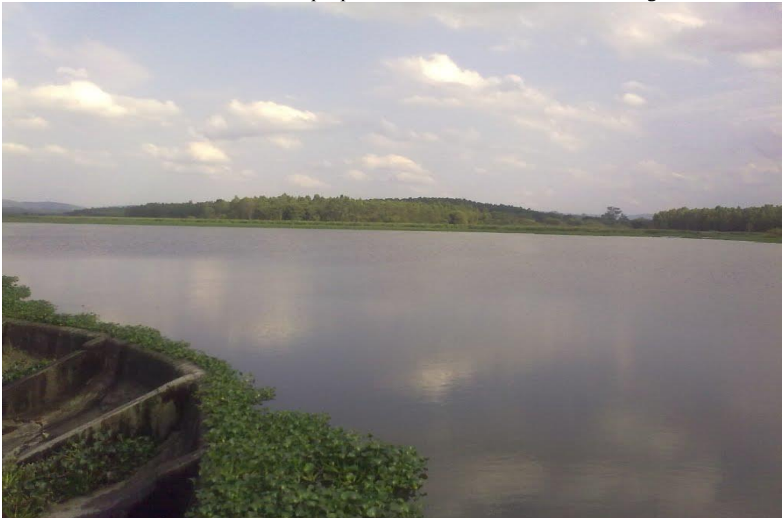
FOTO 04: Vista para CGH dos Britos, Igaratinga – MG. Reservatório a montante da PCH Carioca, também de propriedade da “Santanense”. Data: Ago. 2010.
