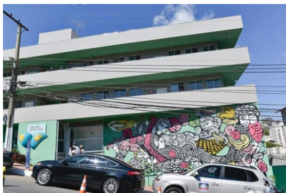
FIGURA 14 - Entrada principal do ECE-BH
