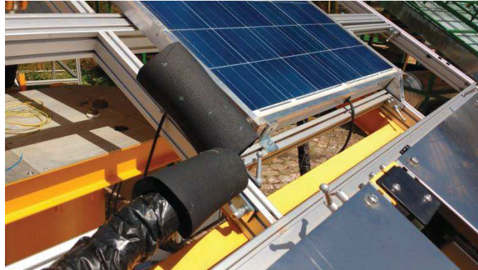
Figura 3.6: Posicionamento do PT100 para medição da temperatura de entrada da água com proteção térmica. Fonte: Autora.
