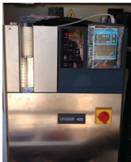
Figura 3.8: Chiller utilizado na regulagem de temperatura da água. Fonte: Autora.
