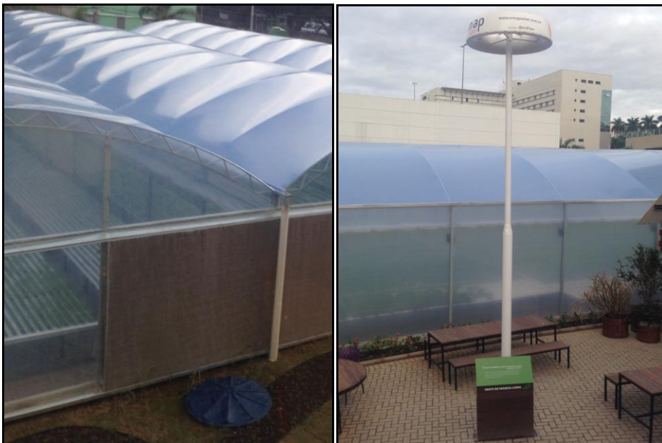
Figura 36 – Captação da Água Pluvial e Poste Fotovoltaico, respectivamente
