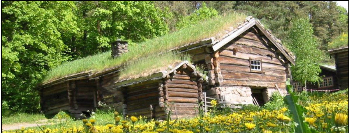
Figura 9 - Exemplo de Sod Roof em Oslo, Noruega
