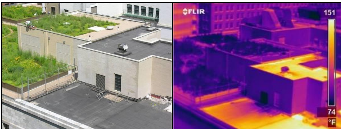
Figura 13 – Cobertura do Chicago City Hall e Sua Visão Infravermelha
