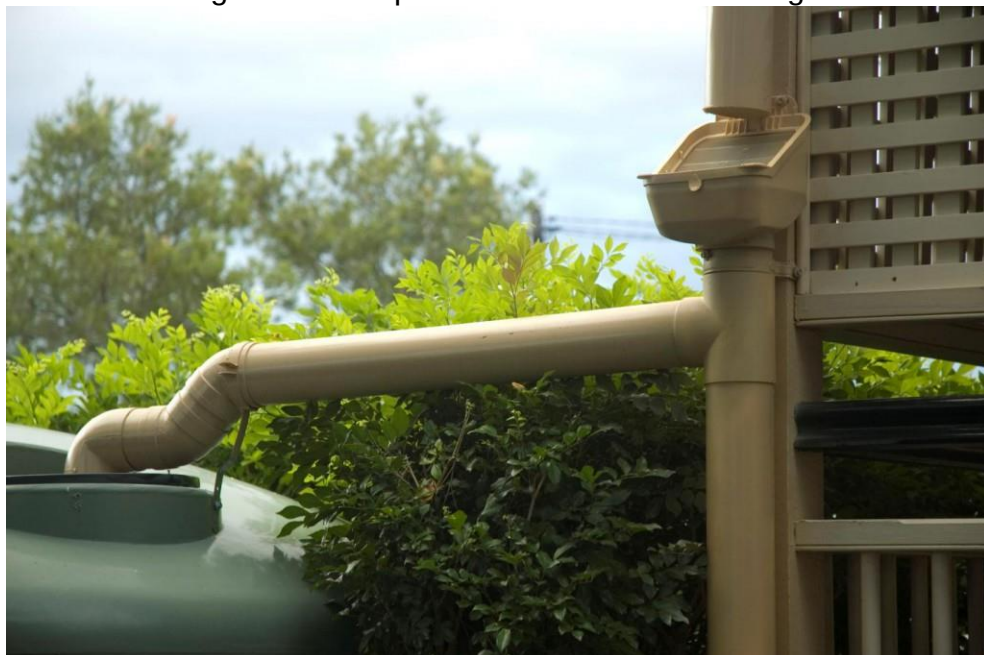
Figura 32 – Separador de folhas Harvesting.
