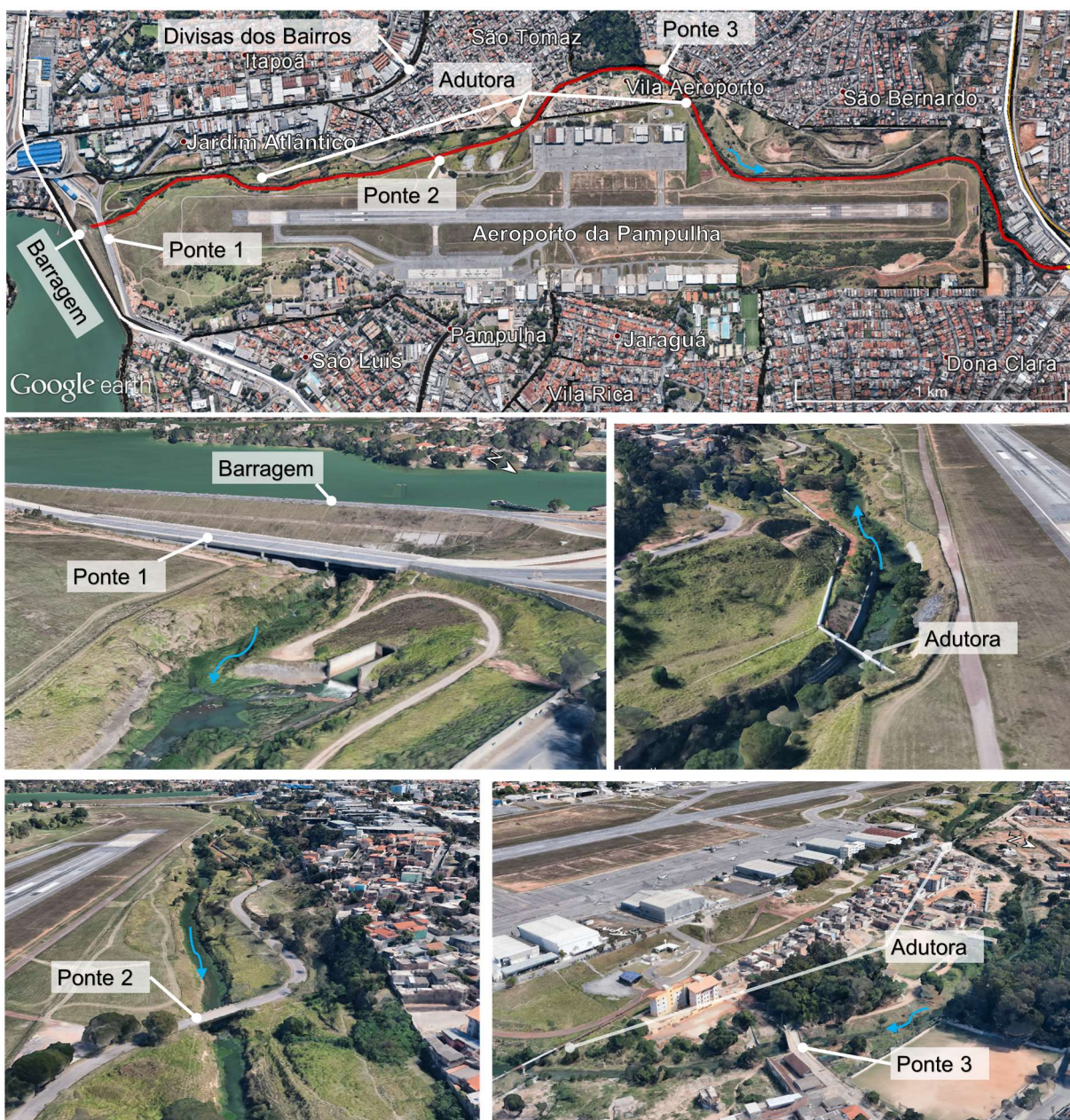
Figura 4.7 – Trecho 1 da área a jusante da Barragem da Pampulha
