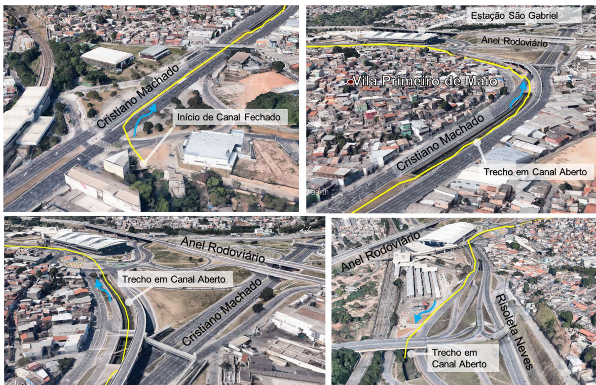
Figura 4.9 – Detalhes do Trecho 2 da área a jusante da Barragem da Pampulha Fonte: Imagem do Google Earth
