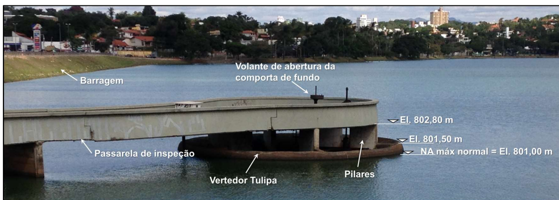
Figura 5.12 – Foto do emboque da tulipa.
