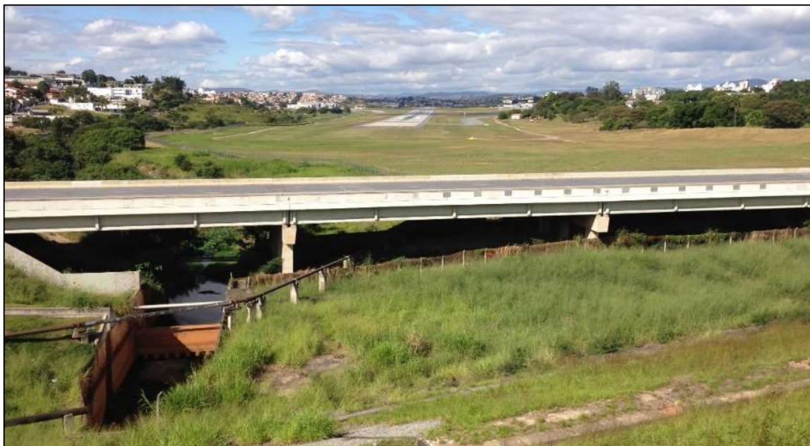
Figura 6.18 – Aeroporto a jusante da Barragem da Pampulha
