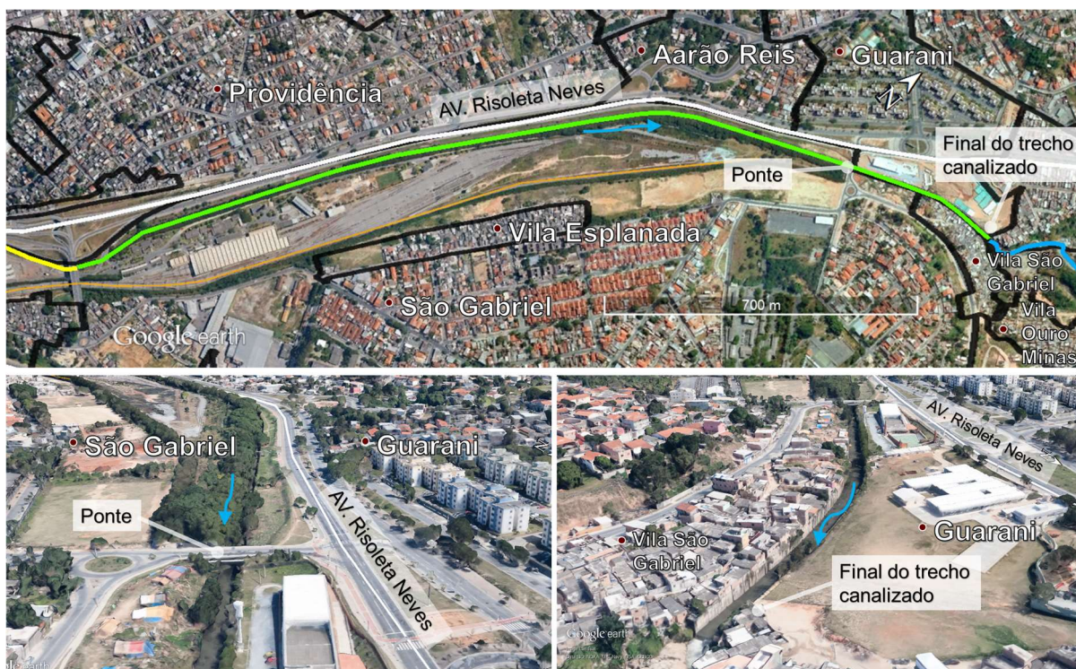
Figura 4.10 – Trecho 3 da área a jusante da Barragem da Pampulha
