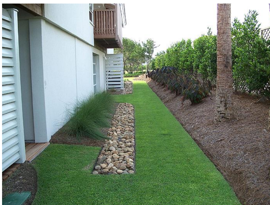
Figura 22: Implantação de trincheira de infiltração
