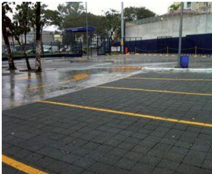
Figura 24: Implantação de concreto poroso em estacionamento
