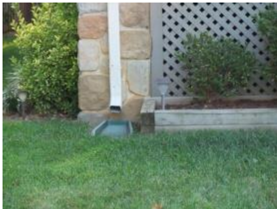
Figura 29: Implantação de desconexão de telhados
