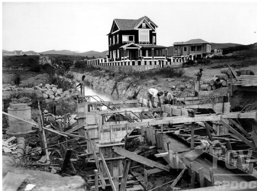
Figura 5: Obras de canalização do córrego do Leitão na rua São Paulo, década de 1920
