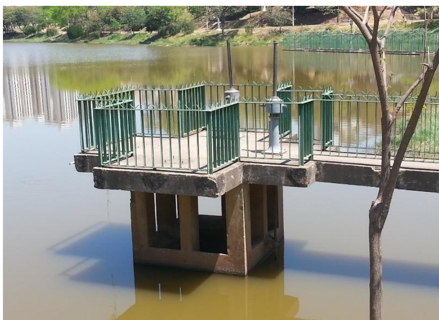
Figura 36: Vertedor auxiliar do reservatório Santa Lúcia do tipo Tulipa
