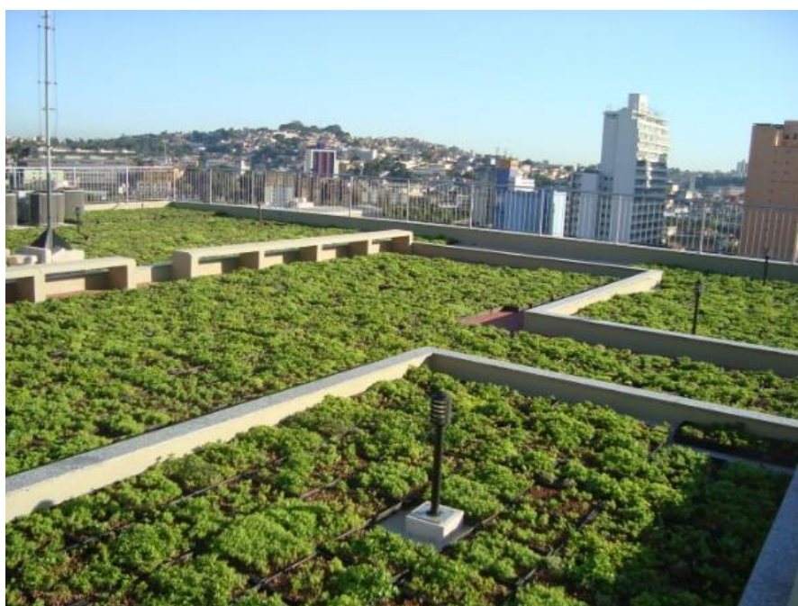
Figura 21: Implantação de telhado verde no Banco do Brasil – Belo Horizonte
