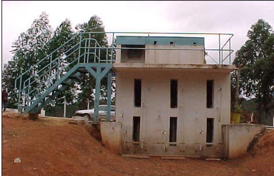
Figura -4.10 Vista do Reator anaeróbico de manta de lodo
