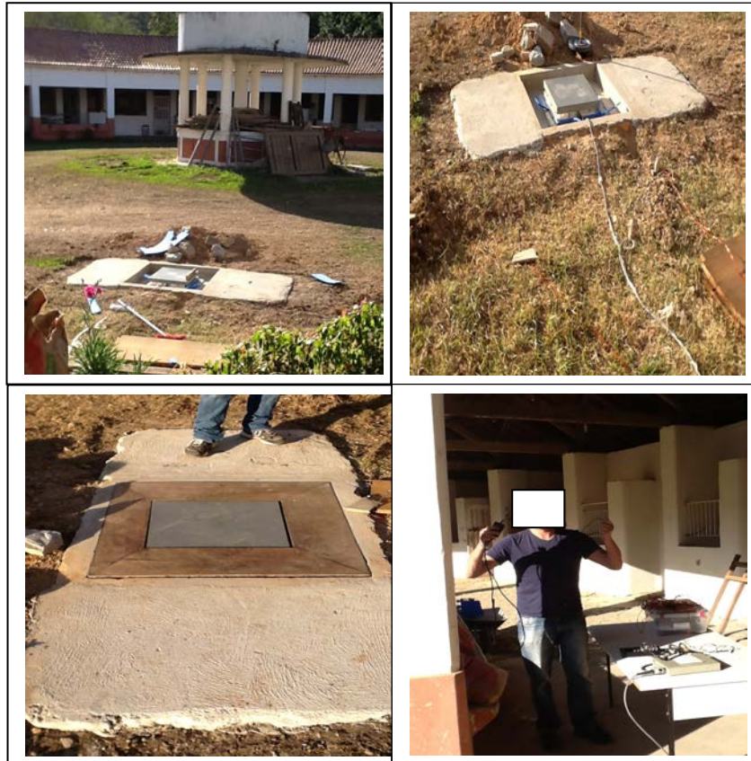
Fig.6.1: Algumas imagens do processo de instalação da plataforma de força na Fazenda Modelo da UFMG em Pedro Leopoldo.
