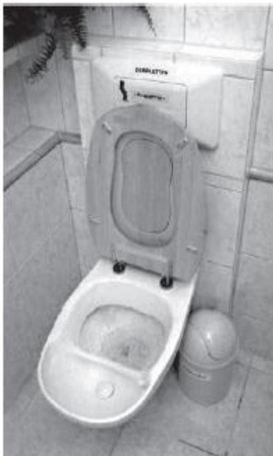
Sua função é conduzir a urina (águas amarelas) para um fim diferente daquele destinado às fezes e ao papel higiênico (águas negras). São dotados de dois compartimentos separados, duas saídas e uma válvula de descarga dual (descarga longa: 4 a 6 litros e descarga curta: 0,15 a 0,2 litros)
