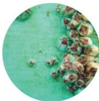
Figura 3.35. Barnáculos crescendo nos defeitos do revestimento [www.coatingsgroup.com].
