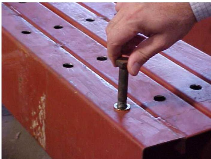
Figura 2-9 – Utilizando o conector rebite e parafuso sextavado em viga mista (Bremer, 2007).
