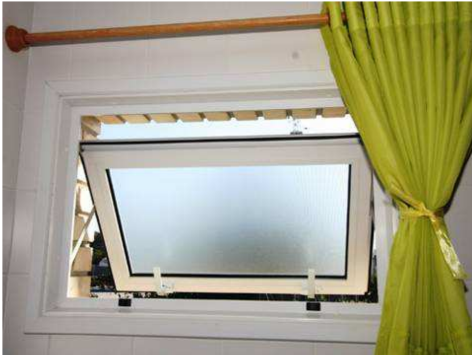
Figura 25 - Esquadria vidro duplo no banheiro.
