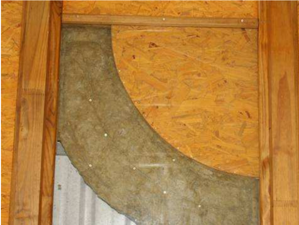
Figura 29 - Visor indicando as camadas constituintes da cobertura - Sala de jantar.
