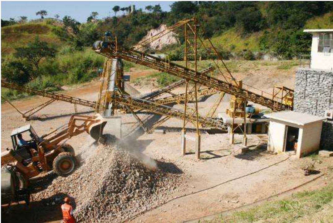
Figura 4 - Estação de reciclagem de entulho em Belo Horizonte/ MG, bairro Estoril.
