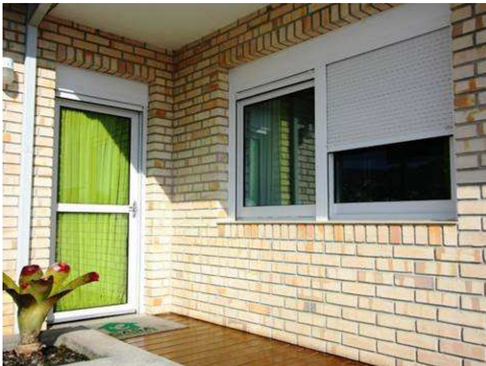
Figura 26 - Esquadria com vidros duplos e persianas externas em PVC - quarto de solteiro.
