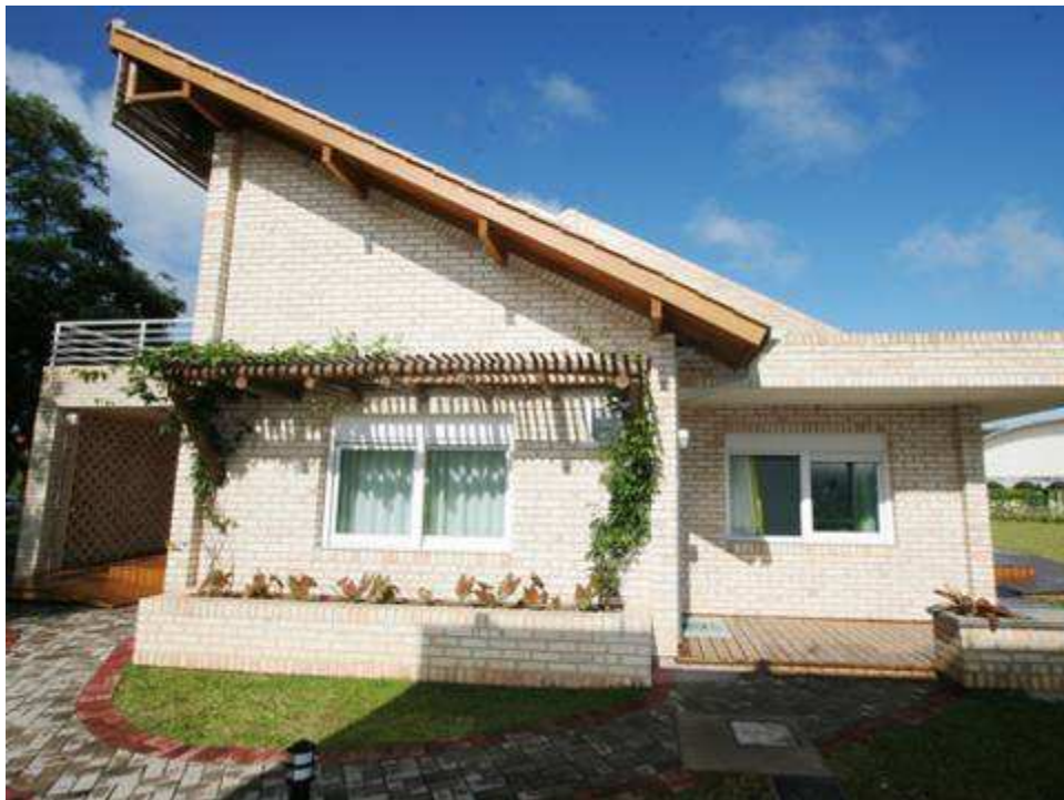
Figura 13 - Vista da fachada leste da Casa Eficiente, observando-se as janelas dos quartos.
