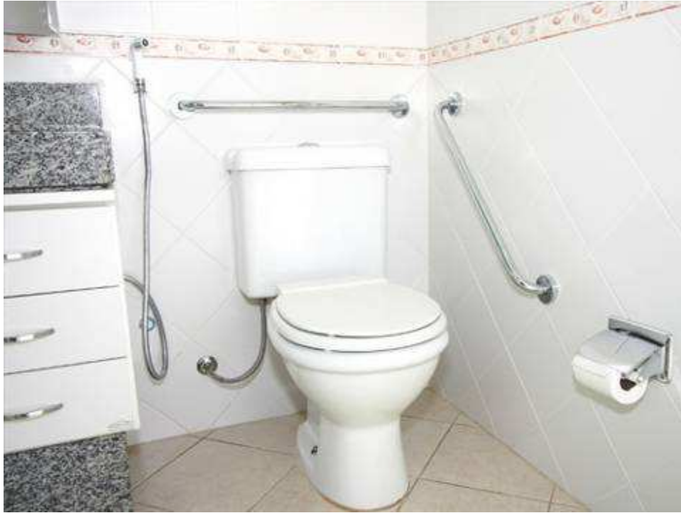
Figura 43 - Barras de apoio junto ao vaso sanitário.
