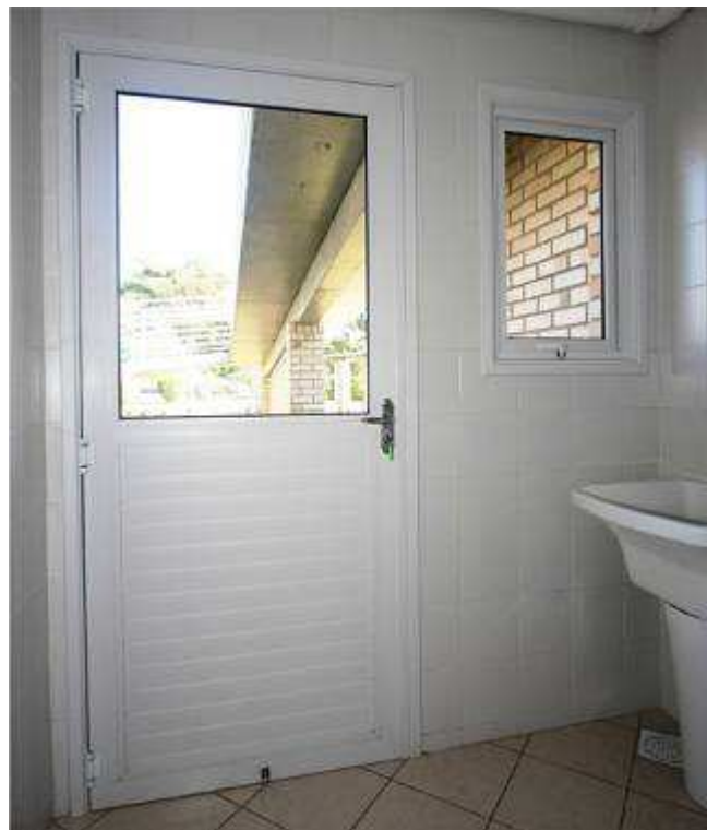
Figura 19 - Porta da Área de Serviço.
