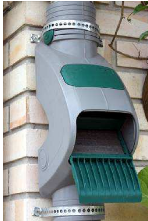
Figura 35 - Dispositivo de descarte de sólidos instalado na tubulação de água pluvial.
