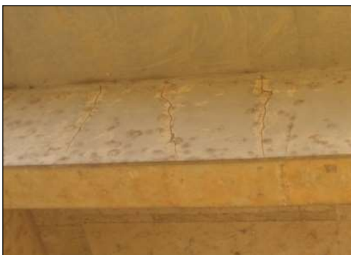
(c) Marcas de fissuras nas vigas principais, que foram recuperadas.
