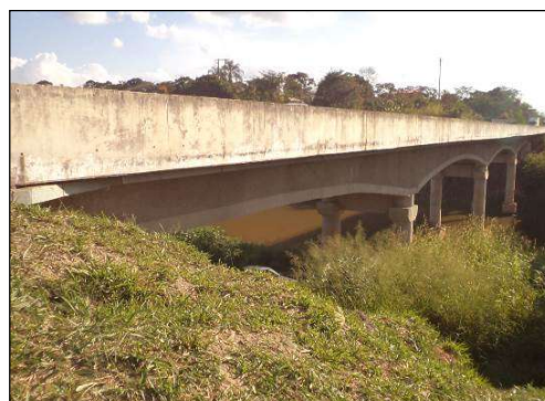
(b) Vista lateral da superestrutura no lado direito da ponte.
