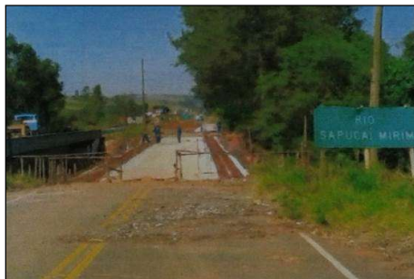
(a) Demolição do pavimento, dos guarda-rodas e guarda-corpos.
