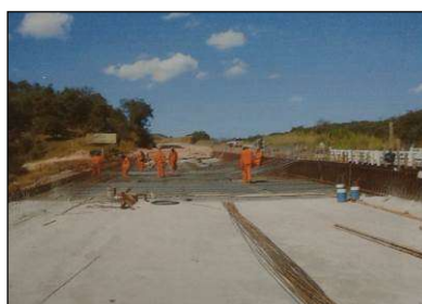
(b) Armação da laje.
