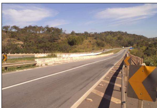
(a) Vista da ponte no sentido Belo Horizonte – Bom Despacho. No detalhe, estreitamento de pista no acostamento.
