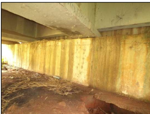
(c) Excesso de umidade e manchas de eflorescência no encontro do lado de Bom Despacho.
