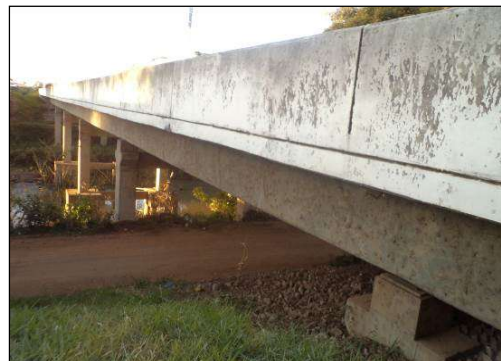
(b) Vista lateral da superestrutura.
