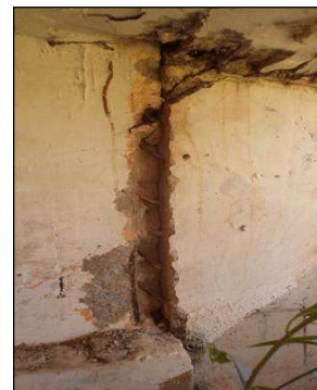
(l) Afundamento da parte alargada da cortina, no lado esquerdo.
