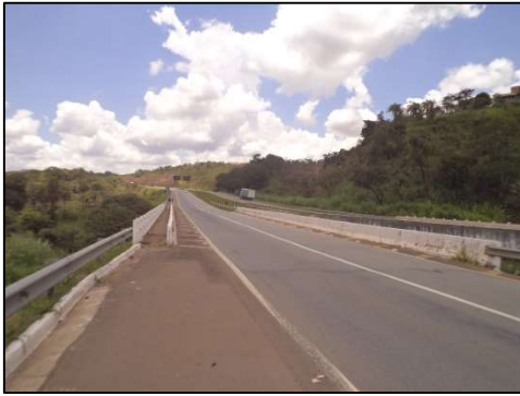
(a) Vista geral da ponte – sentido Belo Horizonte – Bom Despacho. No detalhe, estreitamento de pista no acostamento.
