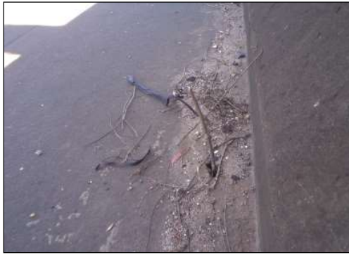
(g) No detalhe, a trinca e o acúmulo de detritos na pista.
