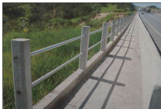
(b) Implantação de novo guarda-corpo.
