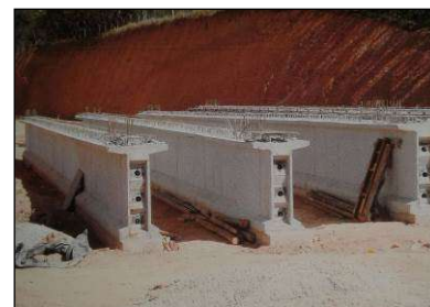
(c) Vigas pré-moldadas utilizadas na superestrutura.
