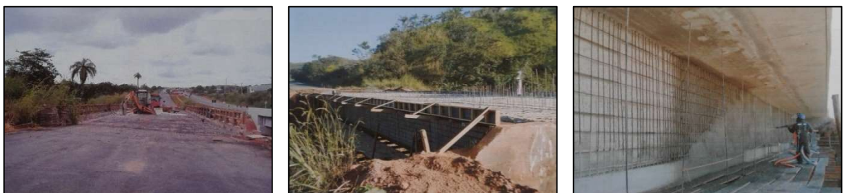
(a) Demolição do pavimento e apicoamento da laje.
