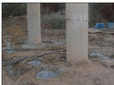
(a) Execução das estacas raiz.
