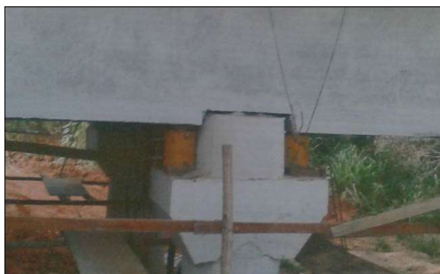
Figura 4.66 – Detalhes da execução da troca de aparelhos de apoio da ponte sobre o Rio Pará.
