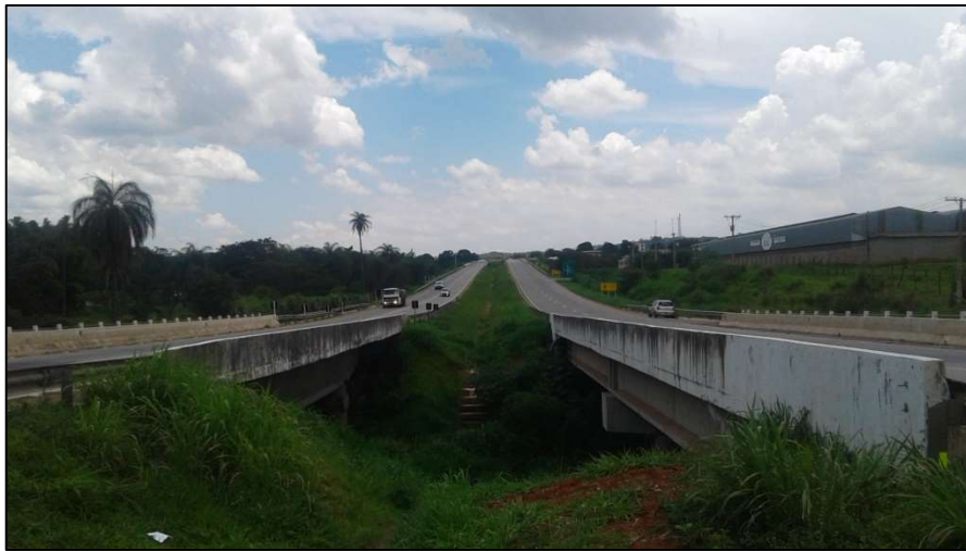
Figura 4.21 – Foto das pontes sobre o Ribeirão Mateus Leme. À esquerda a ponte antiga reabilitada e à direita a ponte nova.
