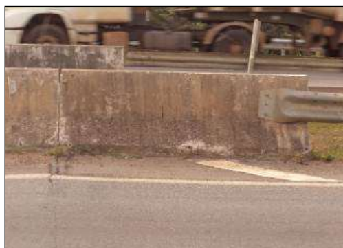
(e) Desalinhamento vertical da barreira New Jersey.
