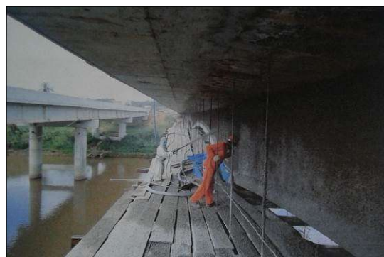
(b) Execução do reforço através da aplicação do concreto projetado (13 cm).
