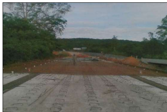
(b) Posicionamento das armaduras para execução da sobrelaje e do alargamento.
