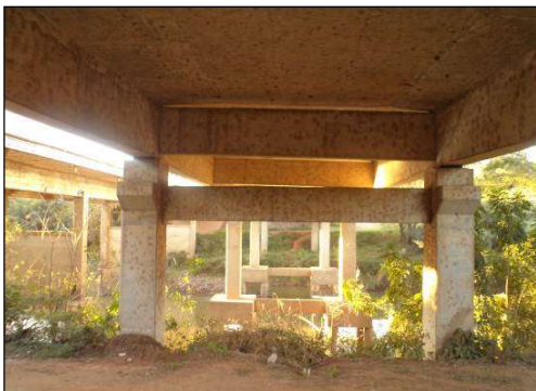
(a) Vista inferior do tabuleiro.
