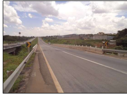
(b) Vista geral da ponte – sentido Bom Despacho - Belo Horizonte.
