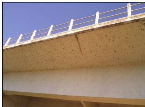
(d) Falha no funcionamento da pingadeira.
