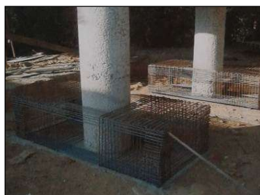
(b) Execução dos blocos de reforço em apoio sobre o solo.
