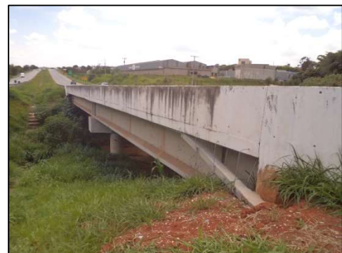
(b) Vista lateral da superestrutura.
