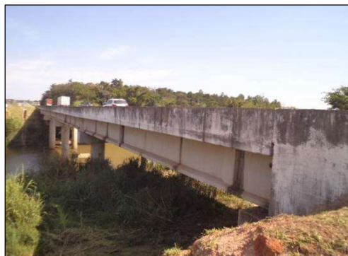
(b) Vista lateral da superestrutura.
