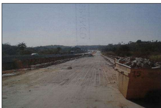
(c) Demolição do pavimento.
