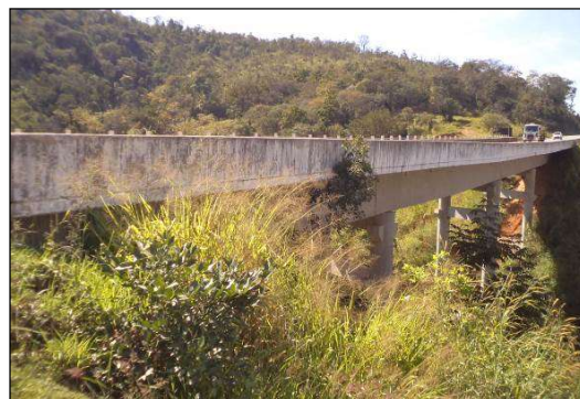
(b) Vista lateral da superestrutura.
