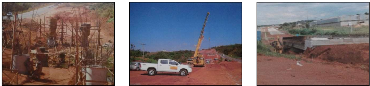
(a) Execução da infraestrutura. (b) Lançamento das vigas principais pré-moldadas. (c) Tabuleiro concluído.
