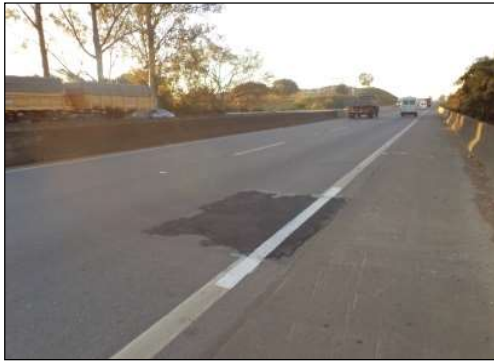
(c) Remendo no pavimento.
