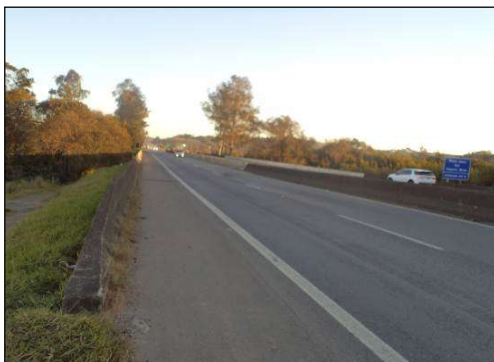
(a) Vista geral da ponte – sentido Belo Horizonte – São Paulo.
