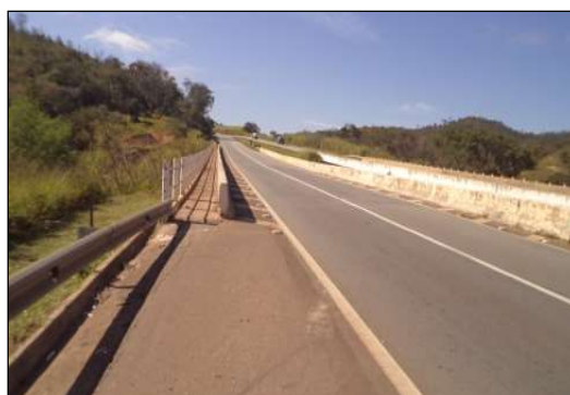
(b) Vista da ponte no sentido Bom Despacho - Belo Horizonte. No detalhe, a passarela de pedestres no acostamento.
