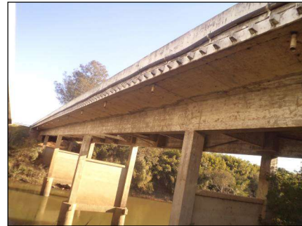
(d) Vista das ancoragens da laje protendida.
