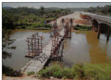
(b) Execução da mesoestrutura.
