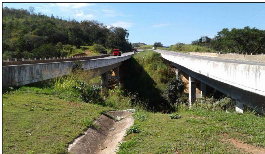
Figura 4.81 – Foto das pontes sobre o Ribeirão dos Paivas. À esquerda a ponte nova e à direita a ponte antiga reabilitada.
