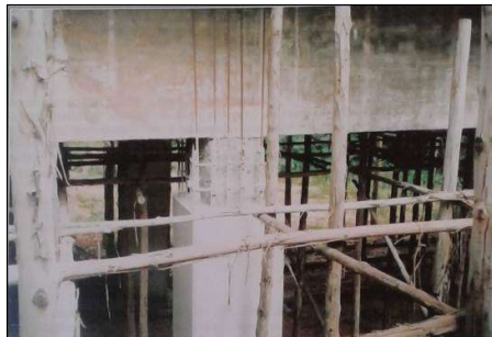
(a) Execução da concretagem do reforço de um pilar.
