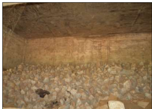
(j) Manchas de infiltração em uma cortina.
