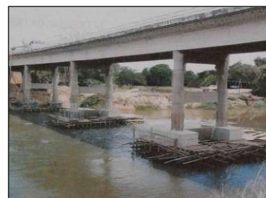
(c) Execução dos blocos de reforço em apoios submersos.
