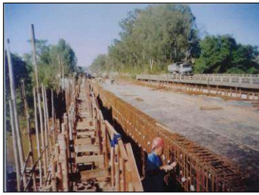
(a) Montagem da armação das longarinas.
