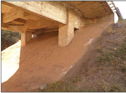
(a) Vista dos pilares extremos no encontro próximo à cortina 2.
