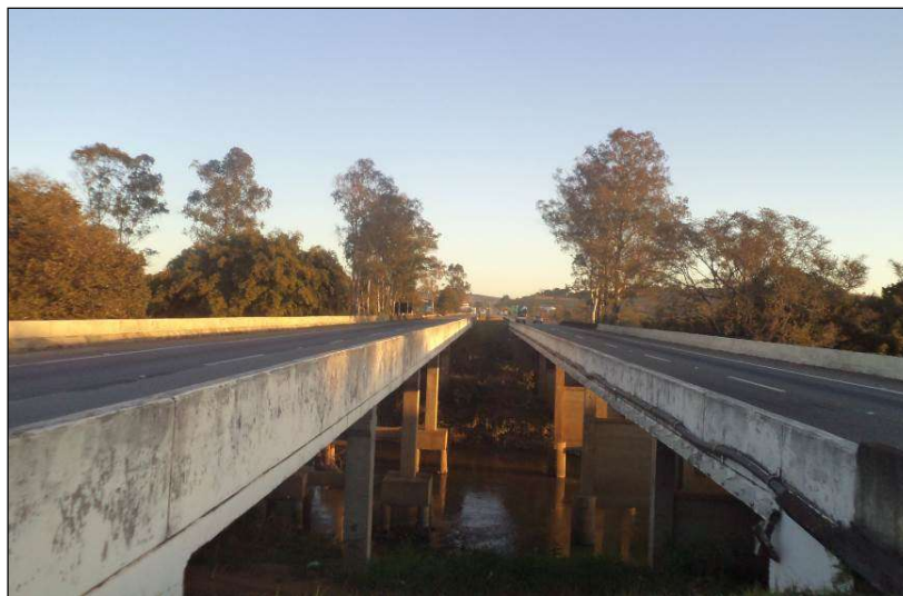
Figura 4.1 – Foto das pontes sobre o Rio Sapucaí Mirim. À esquerda a ponte nova e à direita a ponte antiga rehabilitada.
