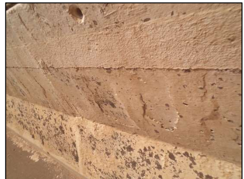
(f) Deslocamentos pontuais na barreira New Jersey.
