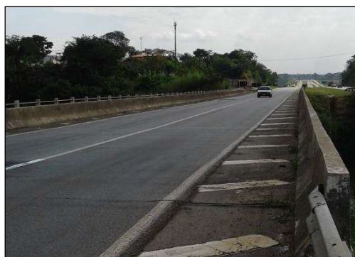
(a) Vista geral da ponte – sentido Belo Horizonte – Bom Despacho.
