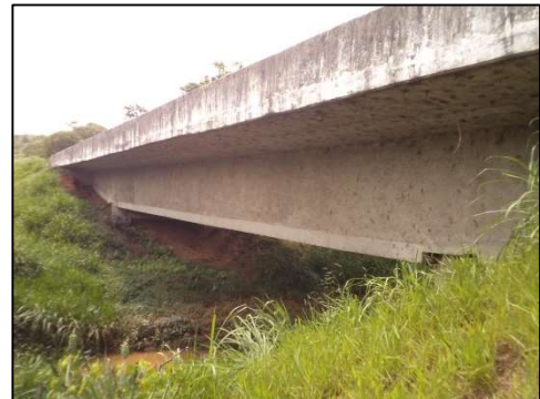
(b) Vista lateral da superestrutura no lado esquerdo da ponte.
