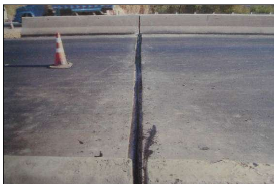
(a) Troca das juntas de dilatação.
