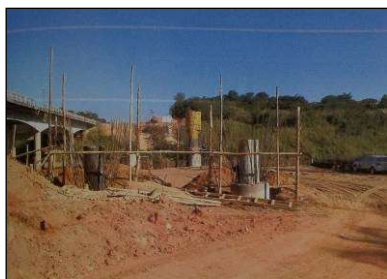
(a) Execução da infraestrutura.
