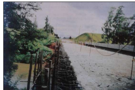
(b) No detalhe, armaduras existentes preservadas, para receber a laje nova.
