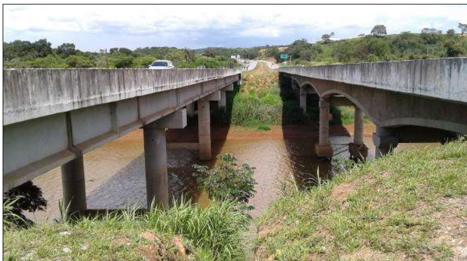
Figura 4.41 – Foto das pontes sobre o Rio Paraopeba. À esquerda a ponte nova e à direita a ponte antiga reabilitada.
