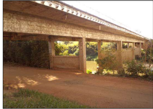
(b) Vista lateral da superestrutura.
