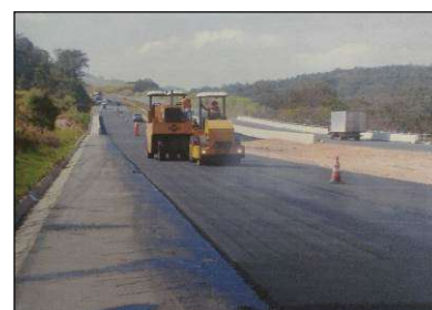
(c) Execução do pavimento sobre a ponte.
