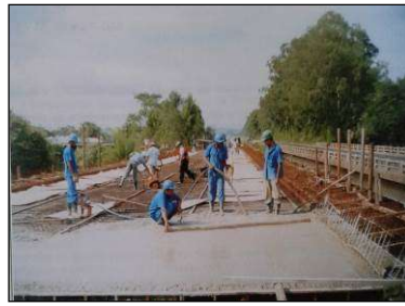
(b) Concretagem da laje.
