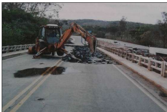
(a) Demolição do pavimento.
