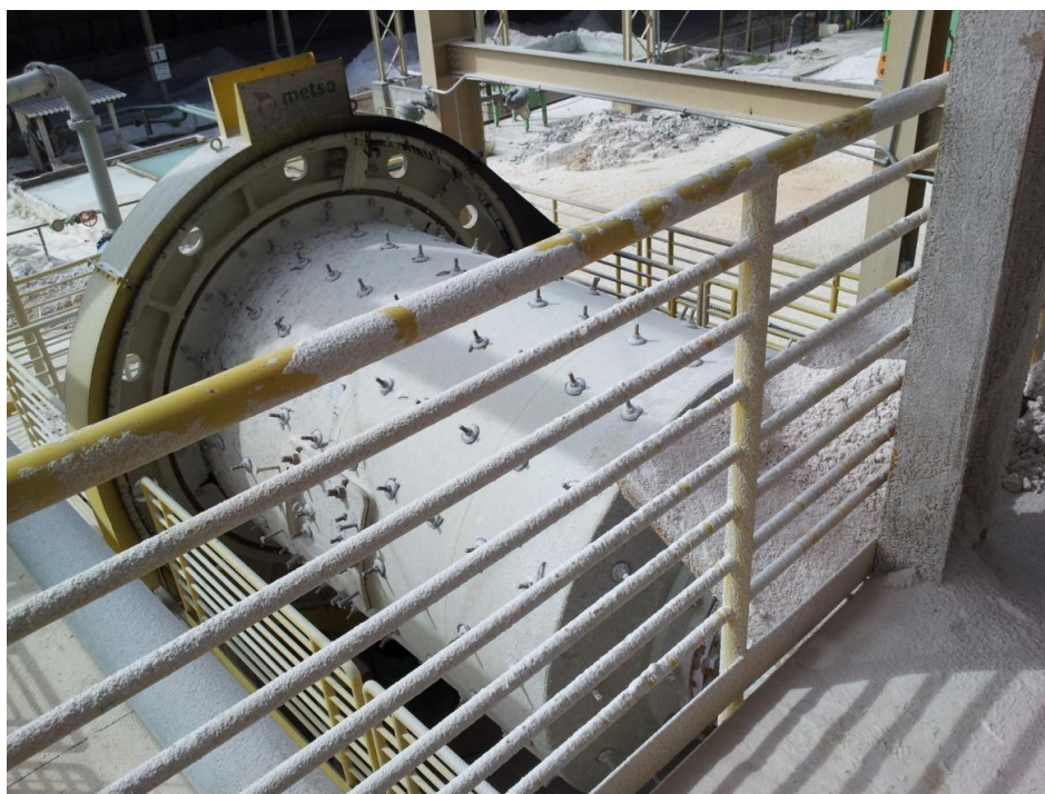
Figura 5.13 – Moinho 4 da usina de concentração de magnesita.
