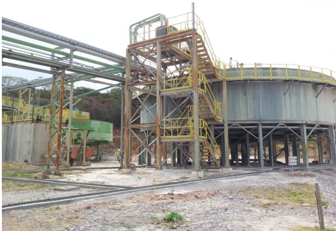
Figura 5.26 – Espessadores de rejeito da unidade industrial.
