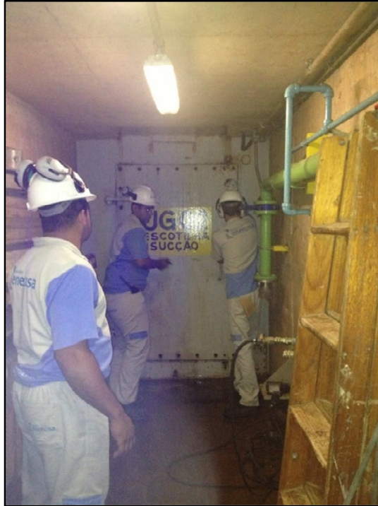
FIGURA 12– Escotilha entrada tubo de sucção UHE Retiro Baixo
