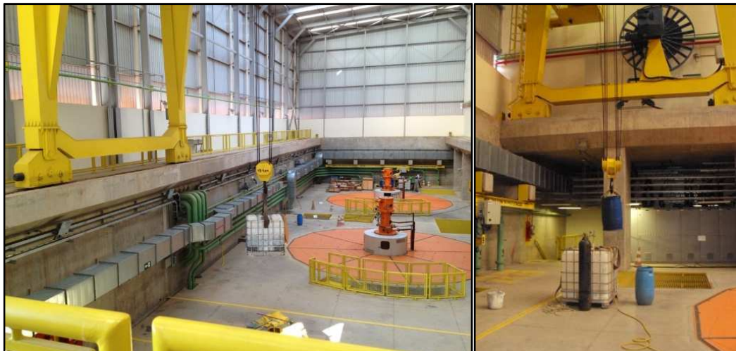
FIGURA 13– Içamento de tanques de peixe na Casa de Força
