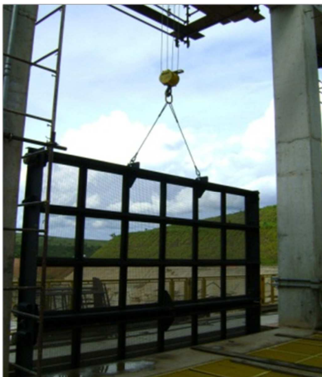
FIGURA 11– Grade Anti Cardume UHE Retiro Baixo FONTE: CCRB, 2009
