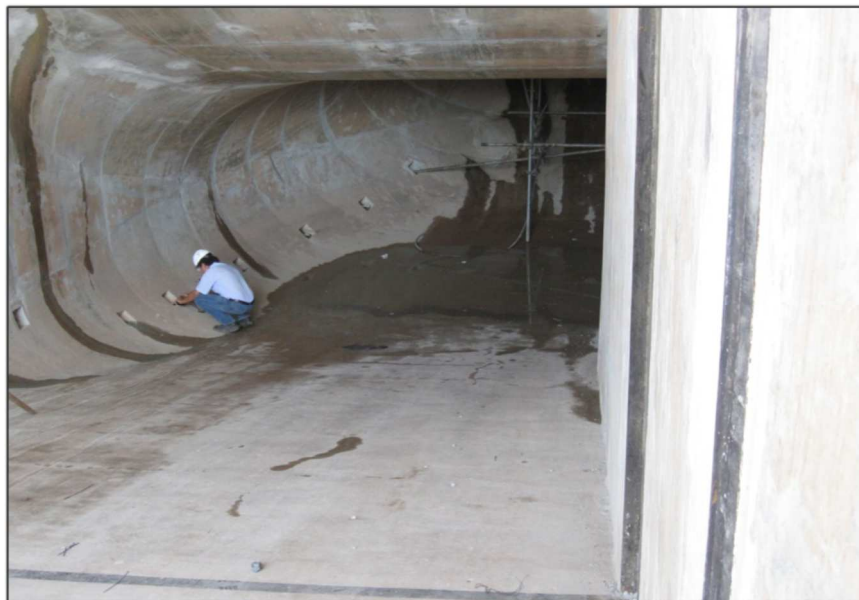
FIGURA 10– Pontos de Injeção de Oxigênio no tubo de sucção
