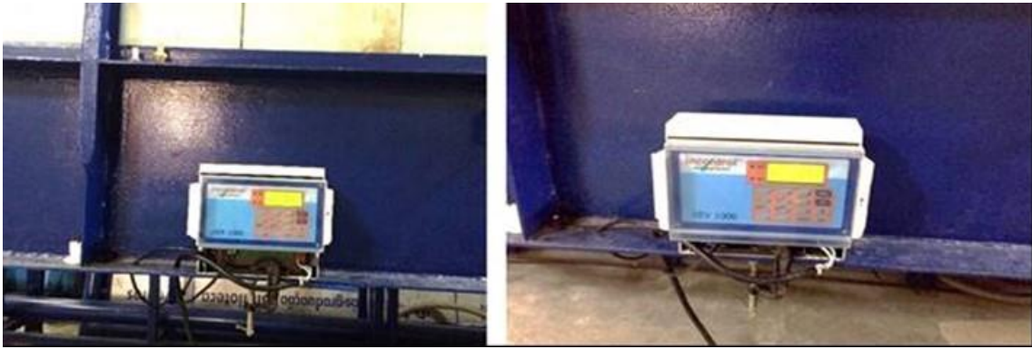
FIGURA 5.12 – Medidor eletromagnético de vazão
