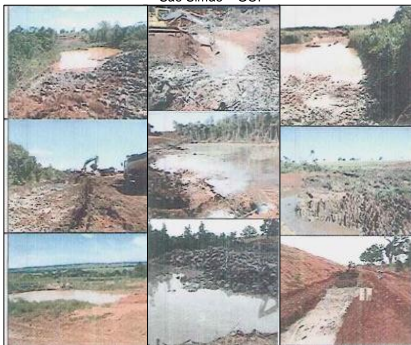
Figura 4: Mosaico de trecho da ferrovia FNS com ocorrência de solos moles no município de São Simão – GO.
