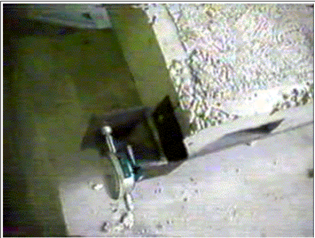
Figura D.3 – Detalhe 1 do relógio medidor do deslizamento de extremidade
