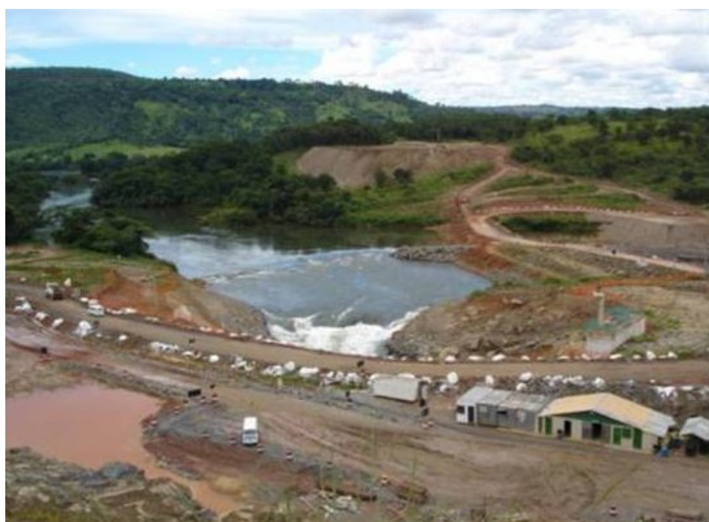
Figura 3.13 – Construção de Capim Branco I
