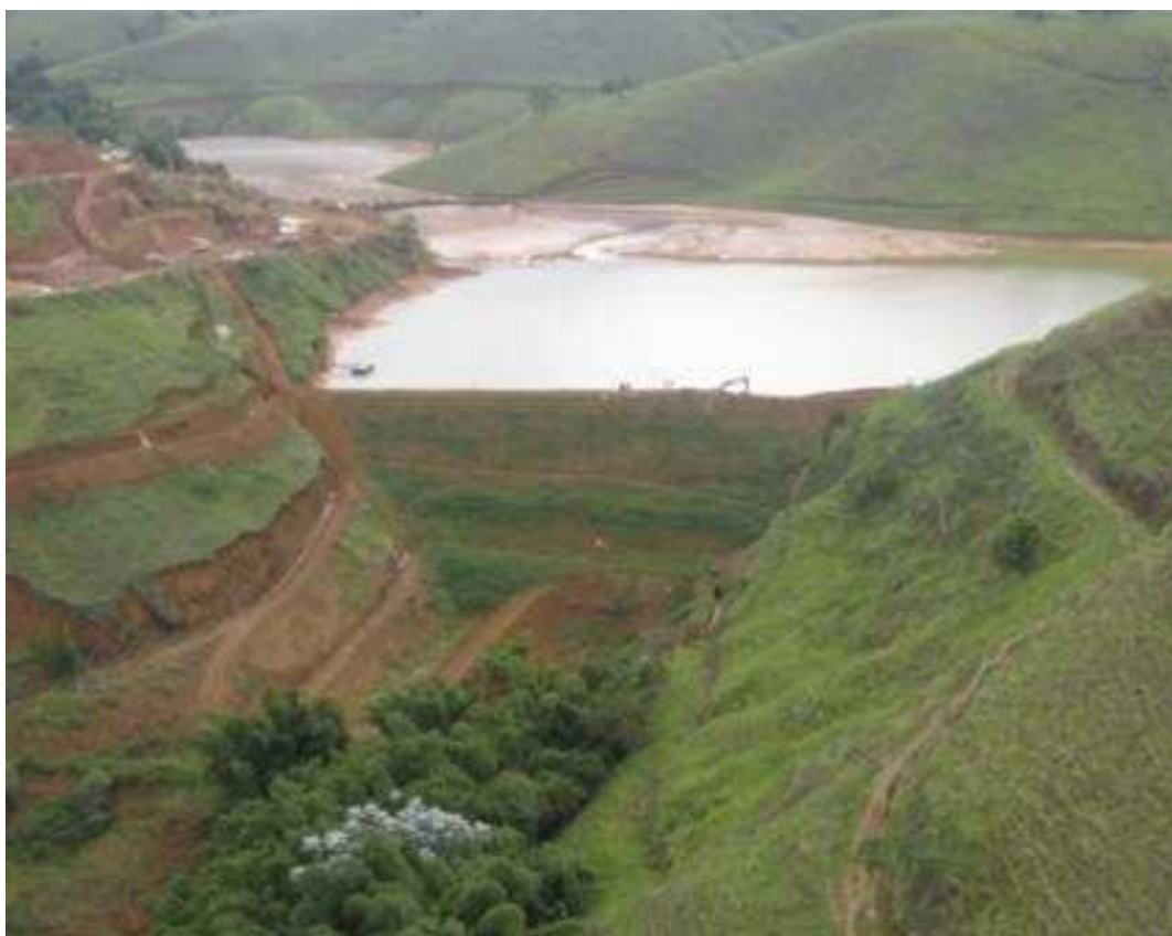
Figura 3.1 - Barragem de contenção de rejeitos da Mineração Rio Pomba Cataguases, Mirai-MG.
