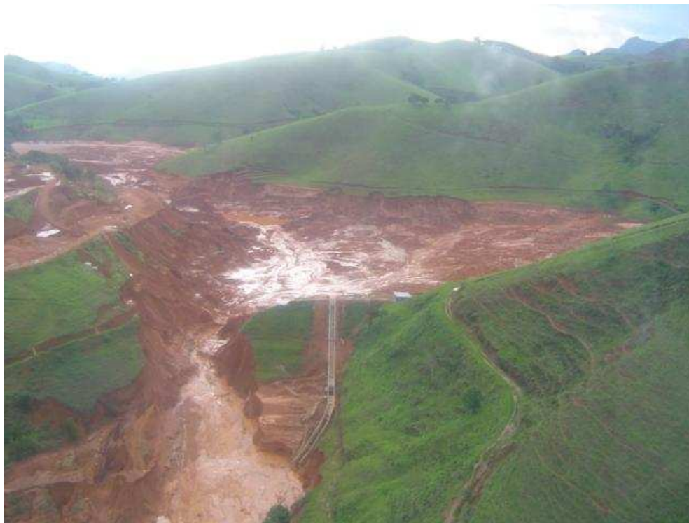
Figura 3.3 – Rompimento da Barragem Rio Pomba Mineração Cataguases, 2007.
