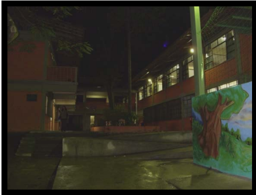
FIGURA 2 – Entrada da EMHR
