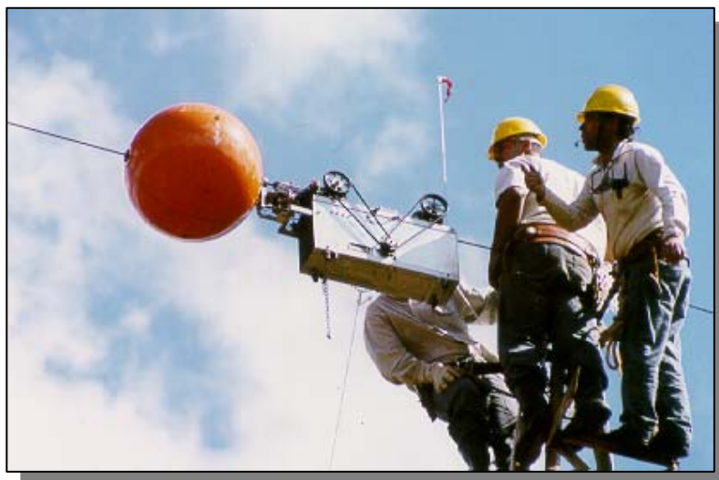
Figura 6.10 – Uso de Robôs para Instalação de Esferas de Sinalização.
