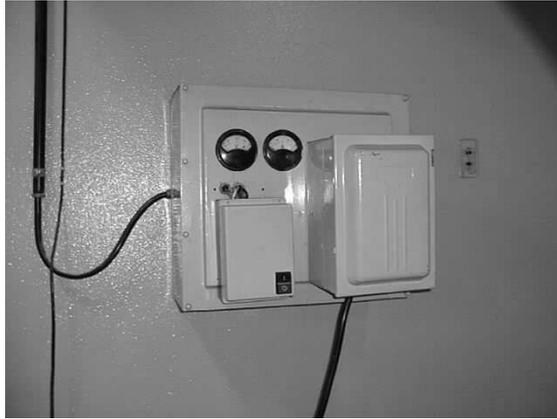
Figura 2-4 - Fotografia do sistema de proteção do motor.
