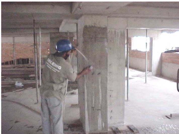
Figura 4.9 – Limpeza e preparo da base de concreto
