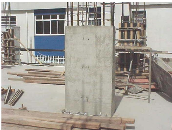
Figura 4.8 – Base de concreto após a desfôrma
