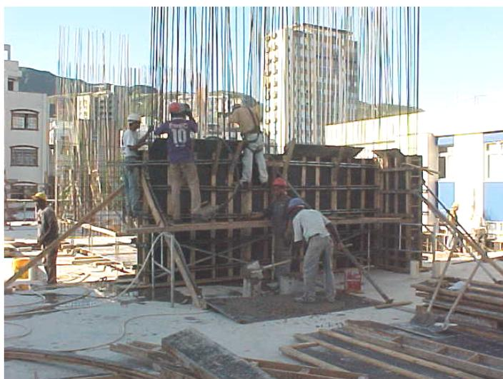
Figura 4.7 – Execução da concretagem
