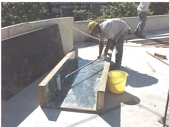
Figura 4.5 – Aplicação de desmoldante nas formas
