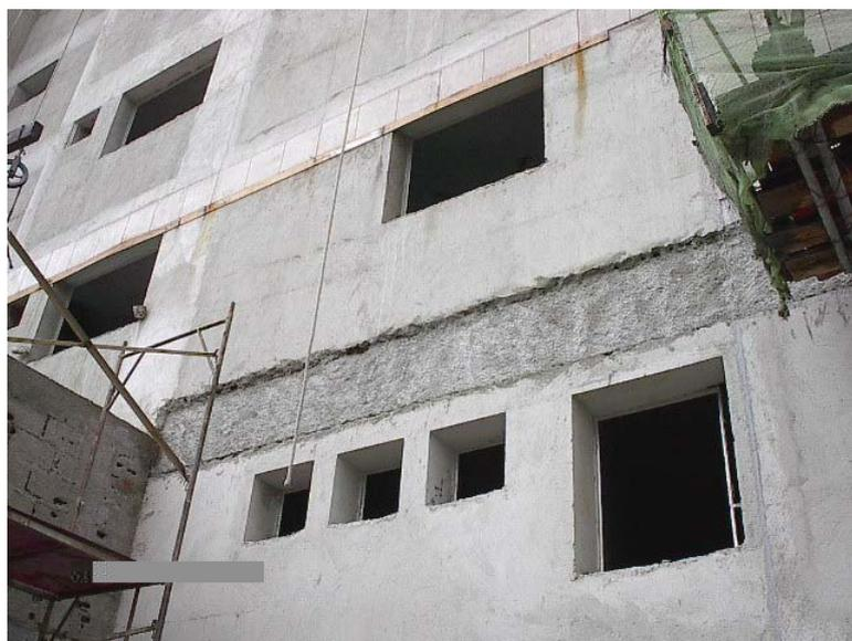
Figura 1.2 – Destacamento do chapisco na região da viga de concreto
