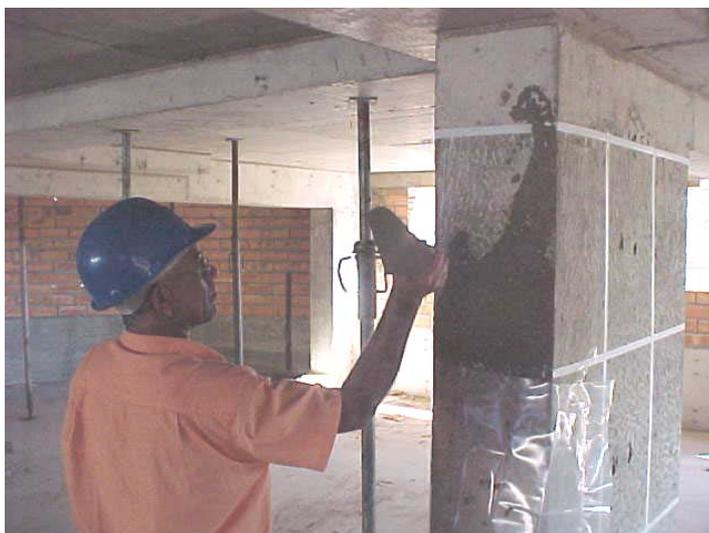
Figura 4.10 – Aplicação da argamassa de chapisco em painéis de teste
