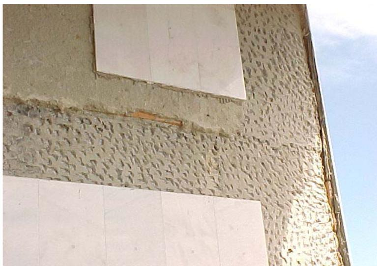
Figura 1.3 – Deslocamento em fachada de edifício
