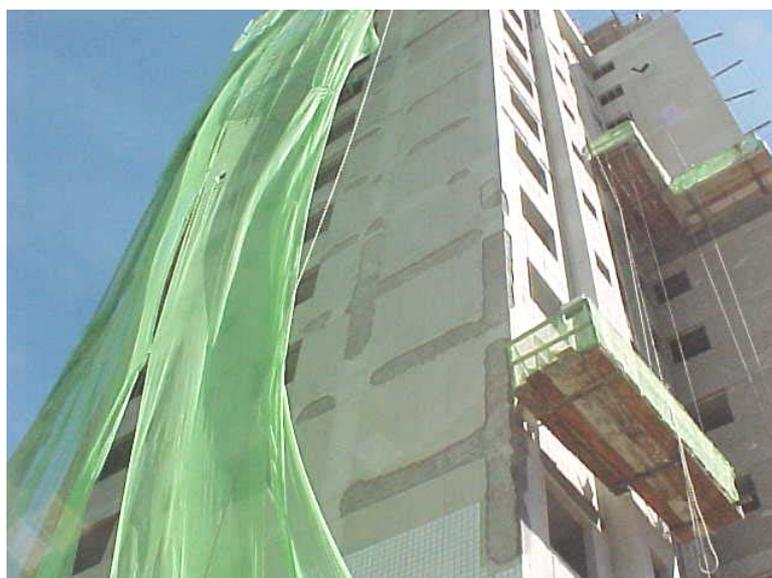
Figura 1.1 – Destacamento de chapisco em fachadas de edifícios
