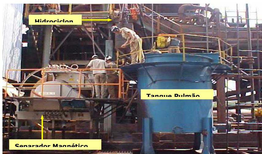
Figura 4.1 Vista Geral Montagem Tanque Pulmão, Hidrociclone e Ferrous wheel
