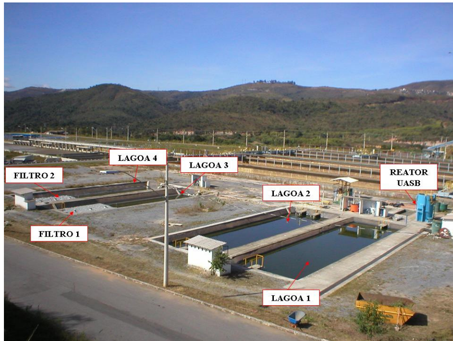
Figura 4.1 - Aparato experimental: Reator UASB, Lagoas 1, 2, 3 e 4 e Filtros 1 e 2
