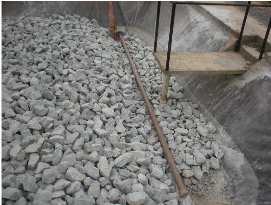
Figura 4.7 - Colocação do tubo perfurado para a saída do efluente do Filtro 2
