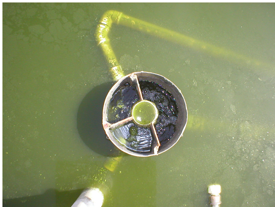
Figura 4.6 - Caixa de distribuição de vazão situada na lagoa 3
