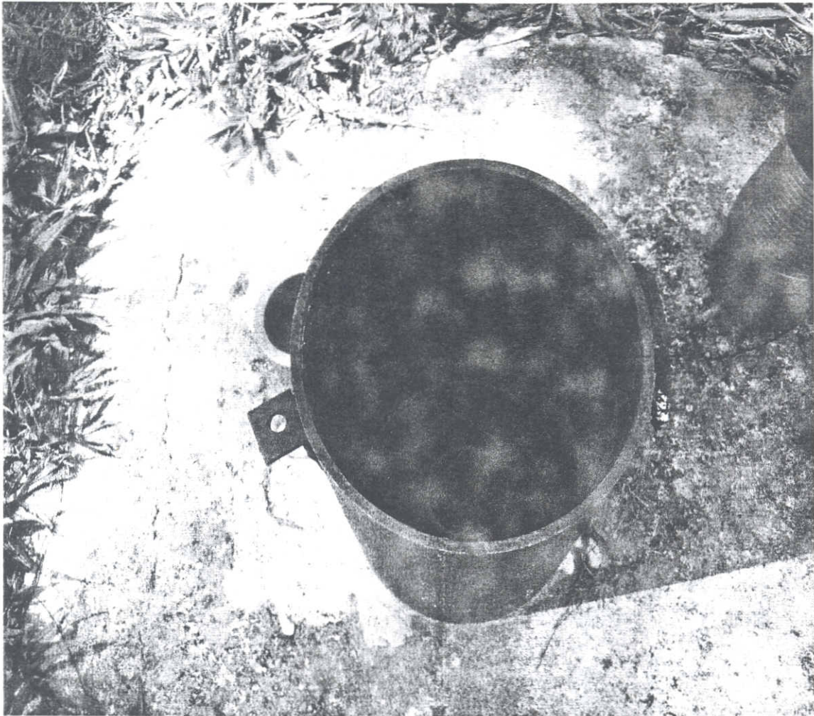
FIGURA 14 – Piezômetro ou Poço de Observação (P2). Cemitério da Paz. 2004.
