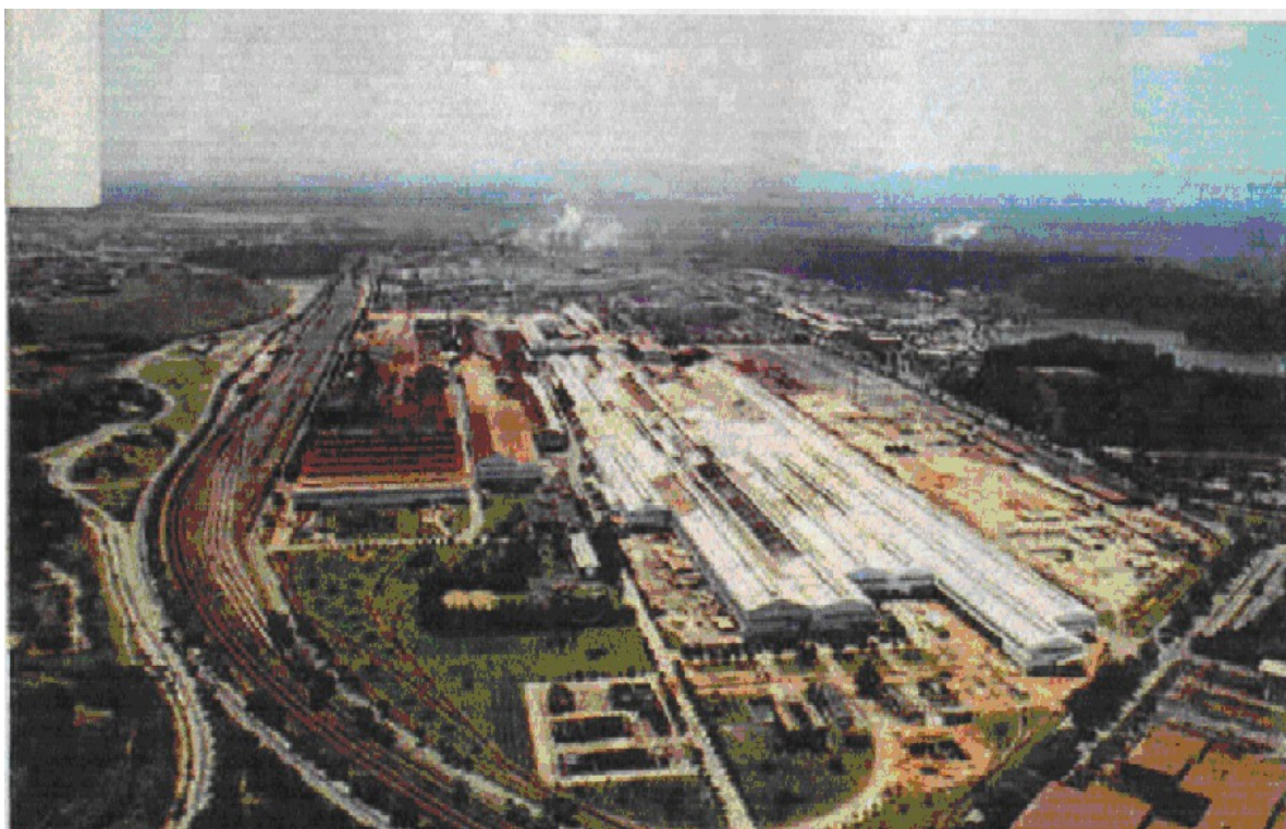
Figura 03 – À esquerda, a BR 381, ao lado da malha ferroviária, no centro, a Usina. À direita, no alto, parte do Parque Florestal e Rio Doce, ao fundo, o centro da cidade. Fonte: Ipatinga: Com você. Por você. Revista informativa da Prefeitura do Município de Ipatinga junho de 2004. p.30.
