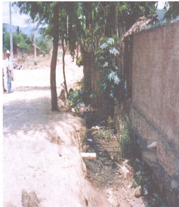
Figura 7: Detalhe da descarga do esgoto sanitário doméstico dos domicílios em Jequié (BA).
