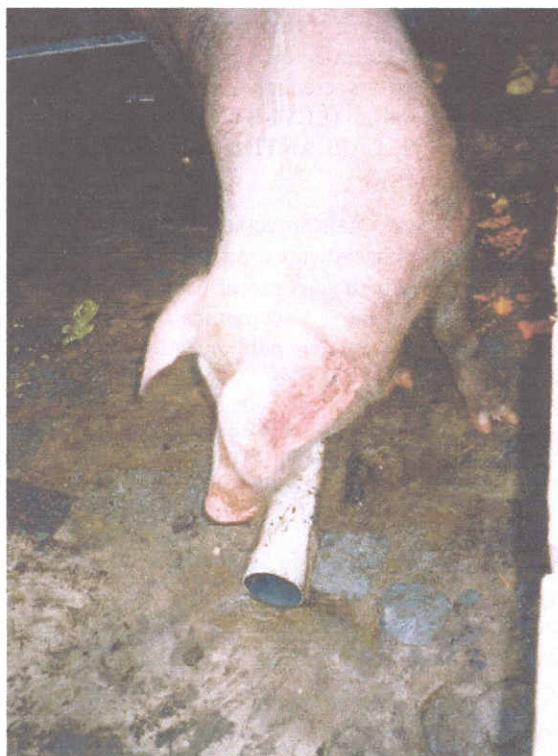
Figura 32: Detalhe cano de pvc ligado direto ao sanitário da residência, Santo Amaro (BA).
