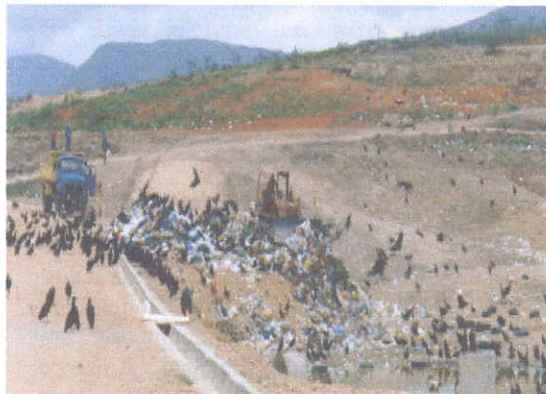
Figura 14: Depósito de lixo municipal após a retirada de todos os porcos que lá viviam. A infestação de moscas que era muito grande, caiu a praticamente zero, Jequié (BA).
