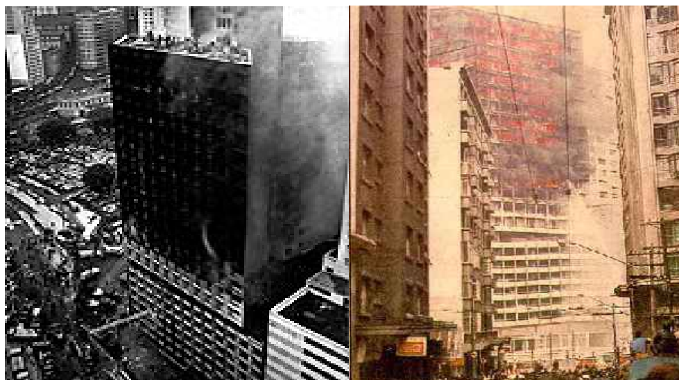
Fig.1.2 – Incêndio ocorrido no edifício JOELMA, São Paulo, 1974.
