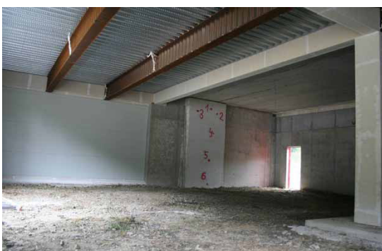
d) Vigas de alma senoidal, com os termopares antes do ensaio
