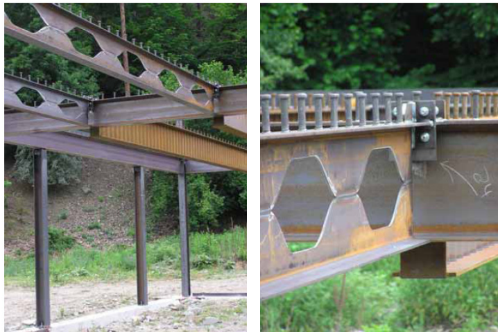
Figura 2.11: Conectores de cisalhamento (Wald & Kallerová, 2009).
