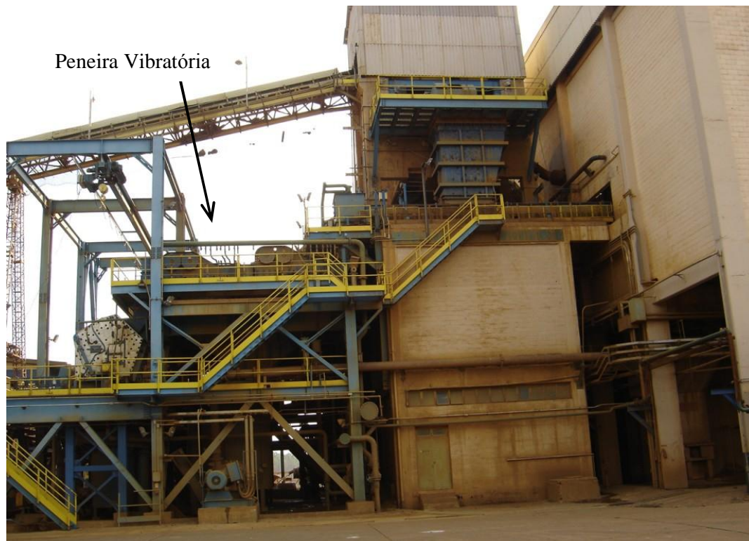
FOTO 1.6 – Vista de um prédio de peneiramento e rebitagem.
