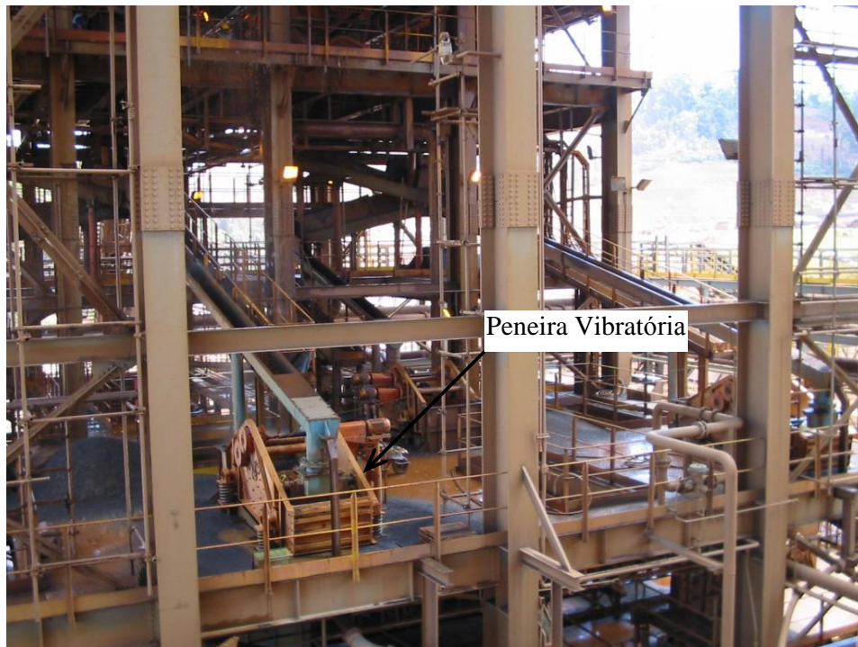
FOTO 1.5 – Vista de um prédio de jigagem.
