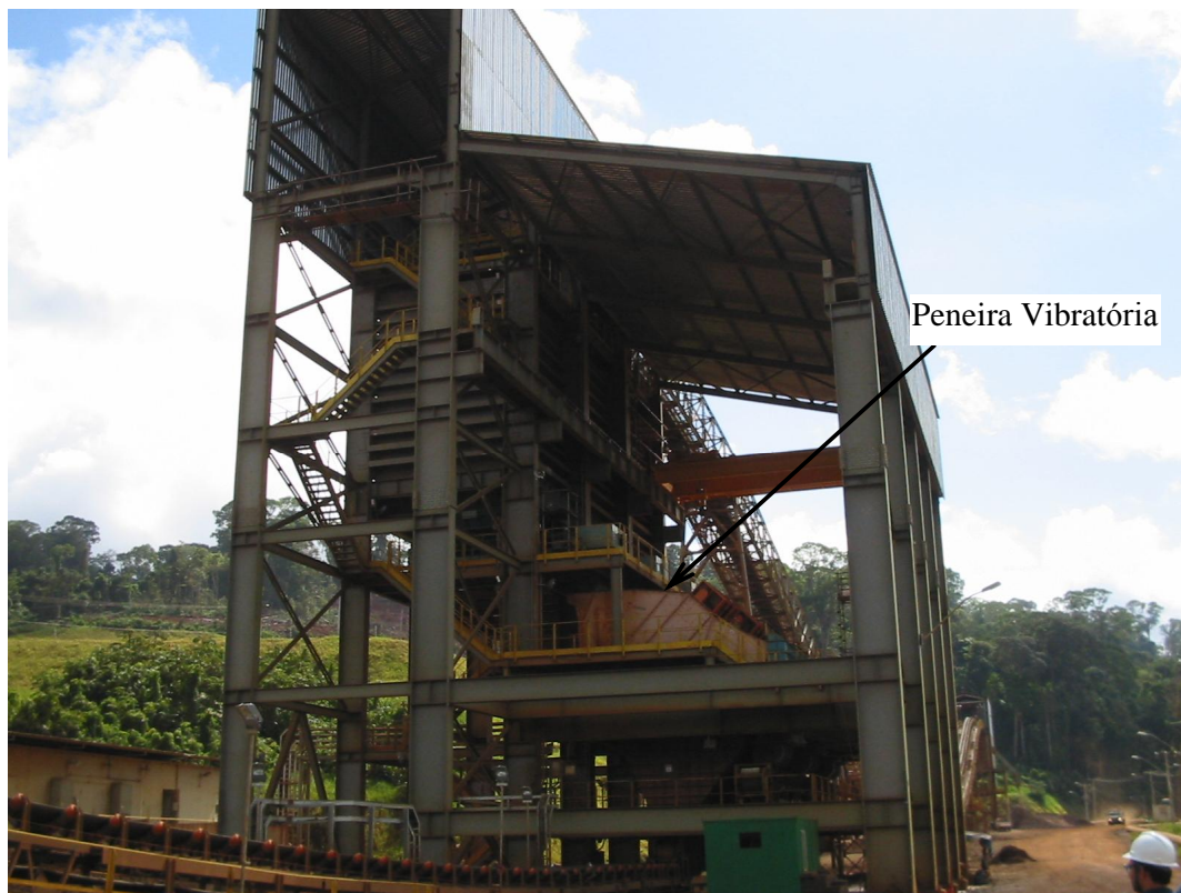
FOTO 1.4 – Vista de um prédio de peneiramento.
