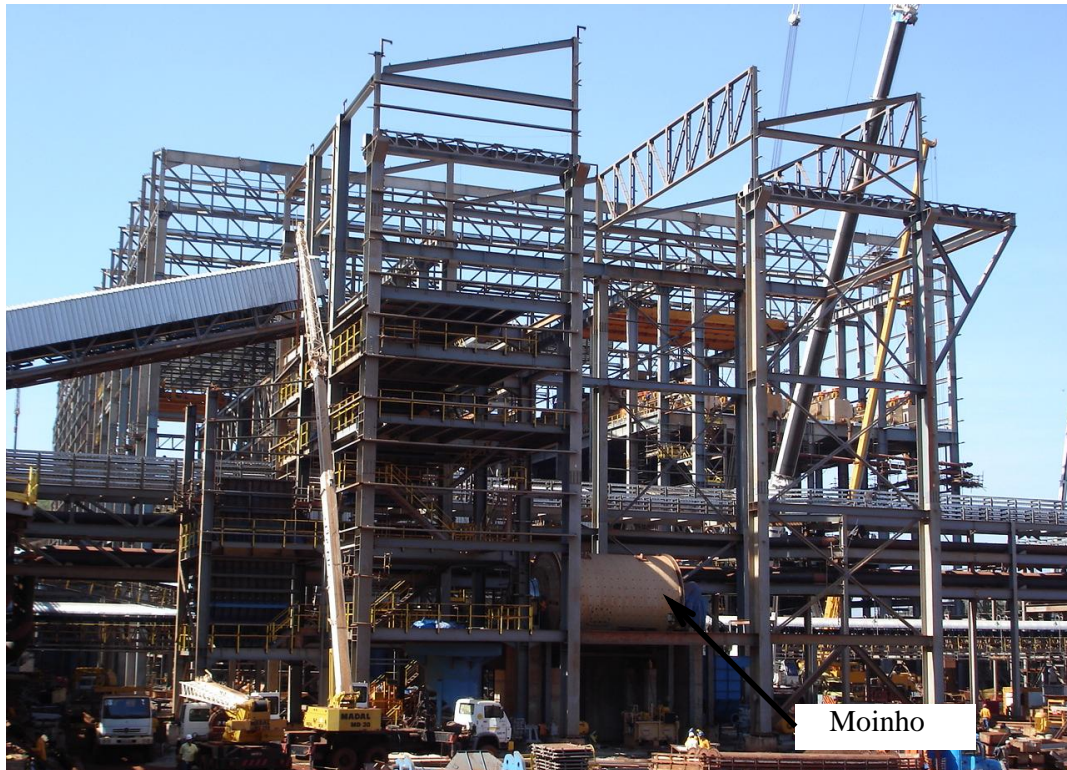
FOTO 1.2 – Vista do prédio da moagem.
