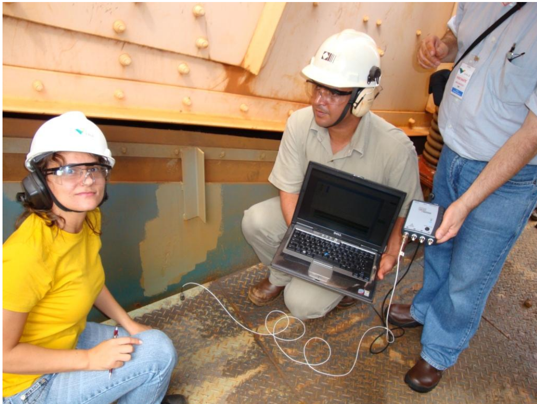
FOTO 6.1 – Montagem dos equipamentos para medição no ponto P3.
