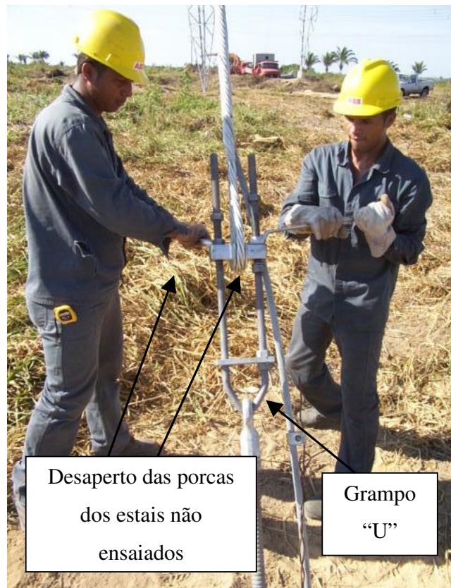
FIGURA 5.8 Alívio de tensão nos estais não ensaiados.
