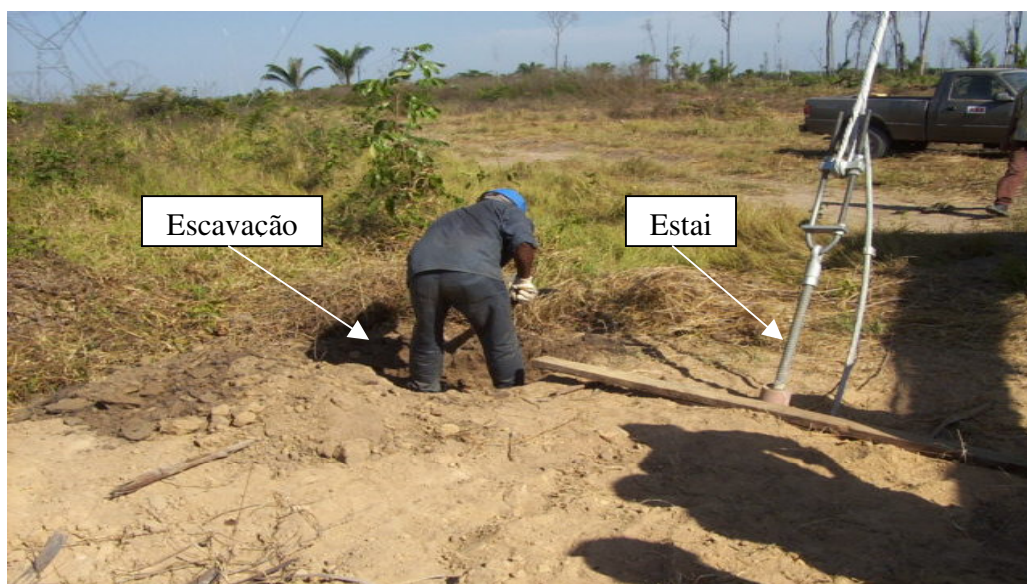
FIGURA 5.3 Cavas para assentamento das patas do Tripé de Ensaio.
