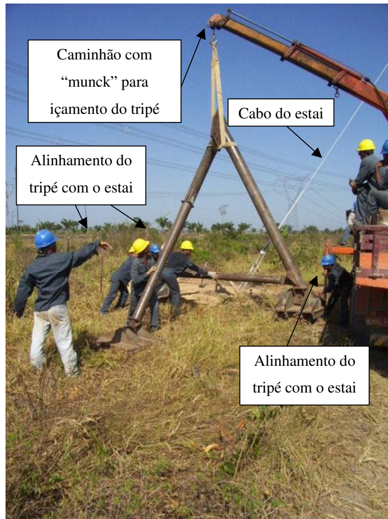
FIGURA 5.5 Fixação da terceira pata do tripé.
