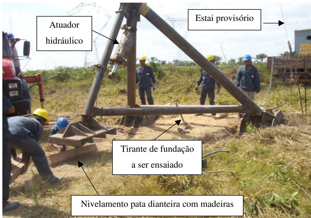
FIGURA 5.11 Adição de madeira para nivelamento do equipamento.
