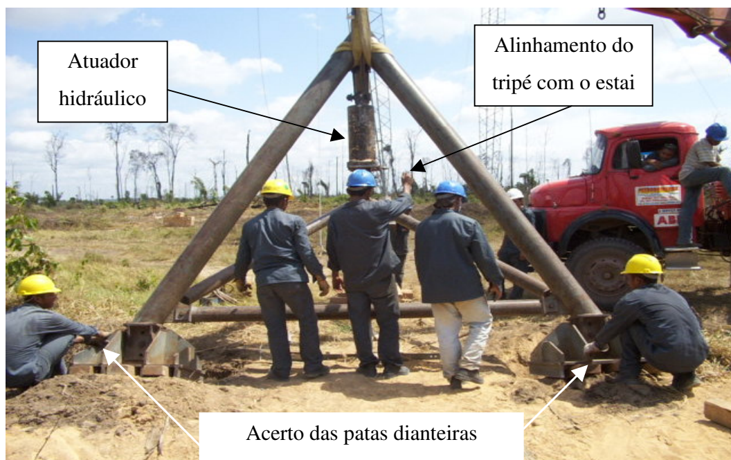
FIGURA 5.10 Alinhamento do equipamento.
