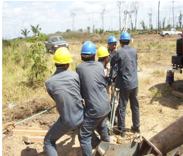
FIGURA 5.9 Retirada do grampo U e do cabo do estai.
