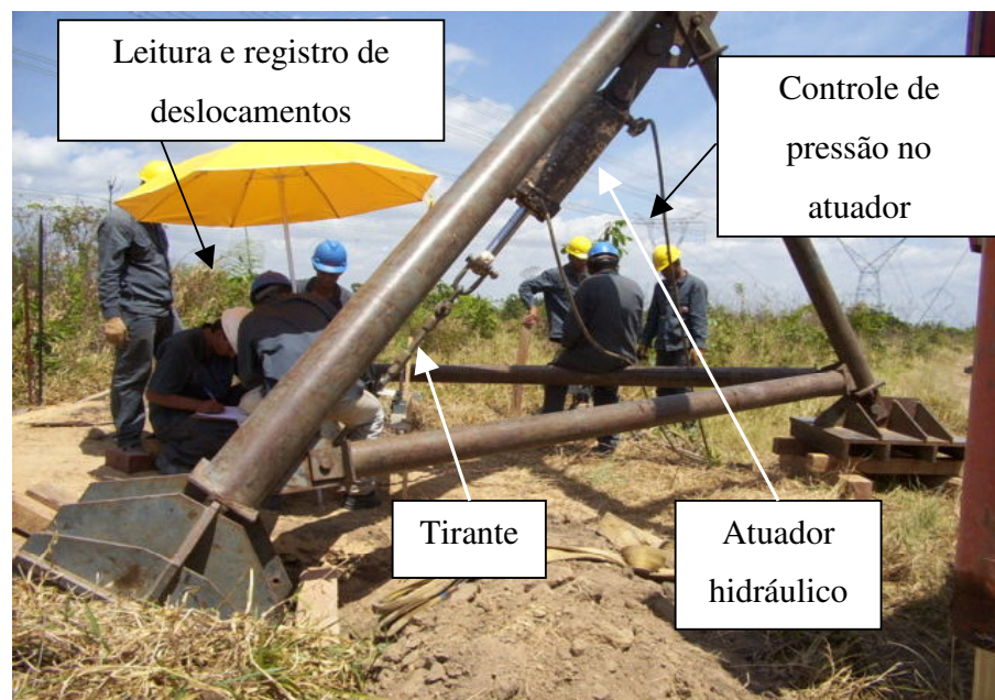
FIGURA 5.15 Detalhe da inclinação do estai ensaiado.
