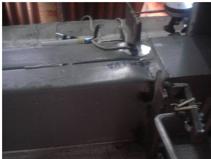
FIGURA 4.13 – Flambagem local da mesa comprimida modelo 4A.
