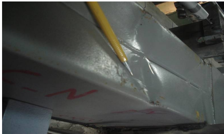
FIGURA 4.7 – Flambagem local da mesa comprimida do modelo 1A.
