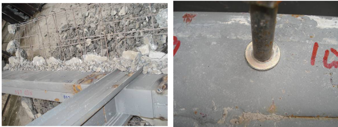
FIGURA 4.27 – Conectores de cisalhamento depois do ensaio.
