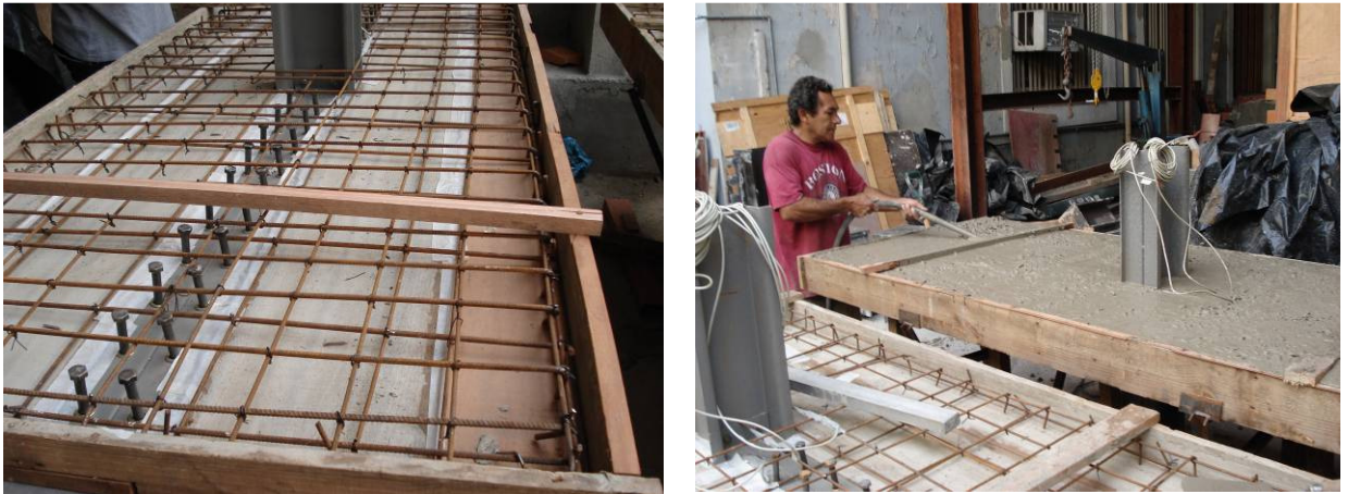
FIGURA 3.15 – Forma montada e concretagem dos modelos BE.
