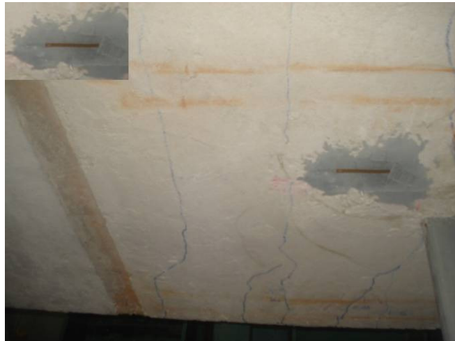
FIGURA 3.25 – Extensômetro para medir a deformação no concreto.
