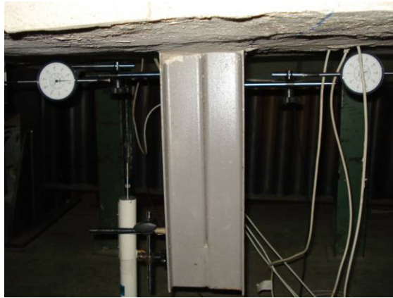
FIGURA 3.23 – Relógios comparadores usados como extensômetros mecânicos.
