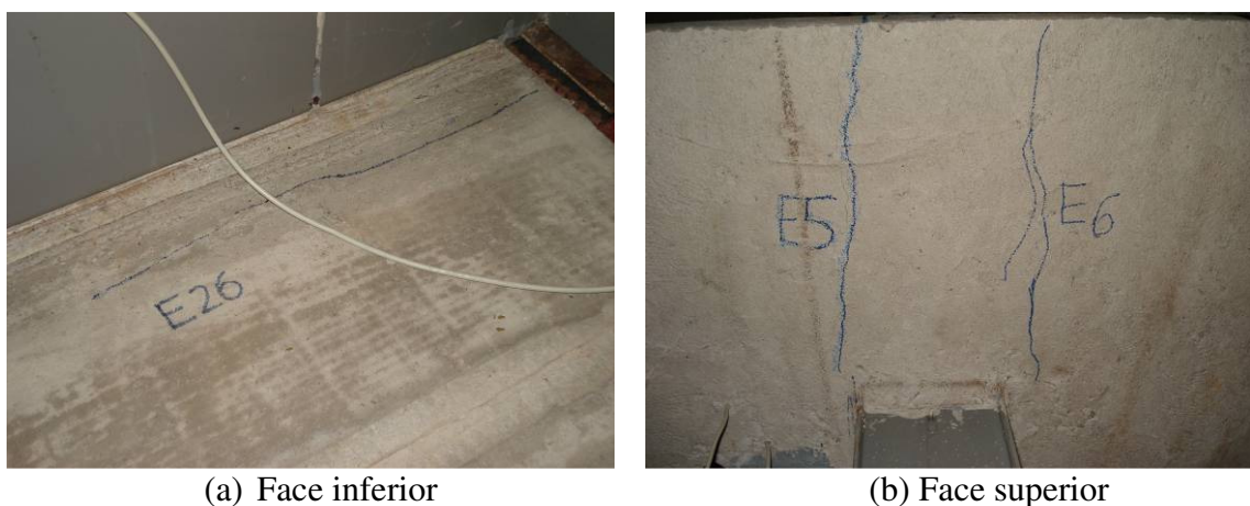
FIGURA 4.37 – Fissuras longitudinais e transversais do modelo 3A.
