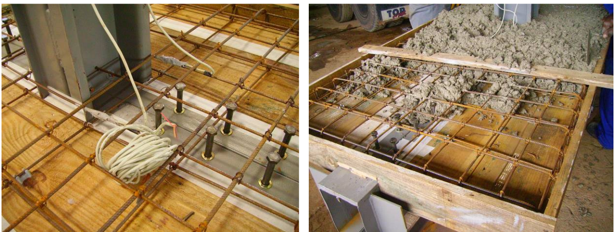
FIGURA 3.14 – Concretagem dos modelos A.
