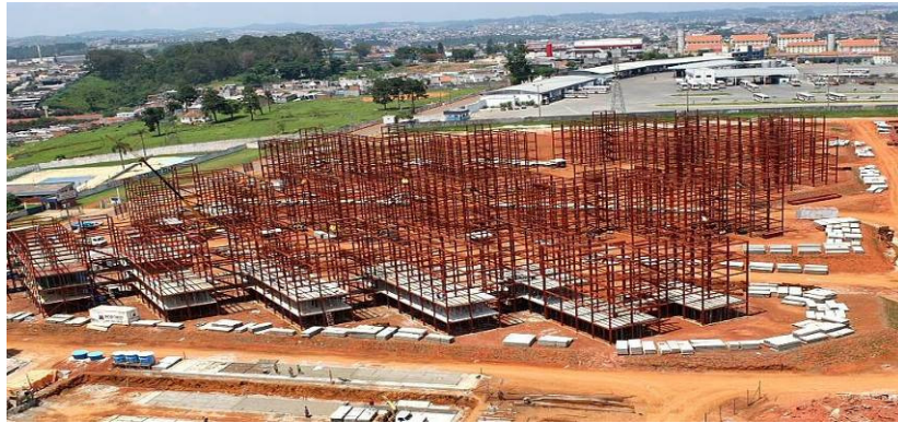
(a) Vista geral da construção.
