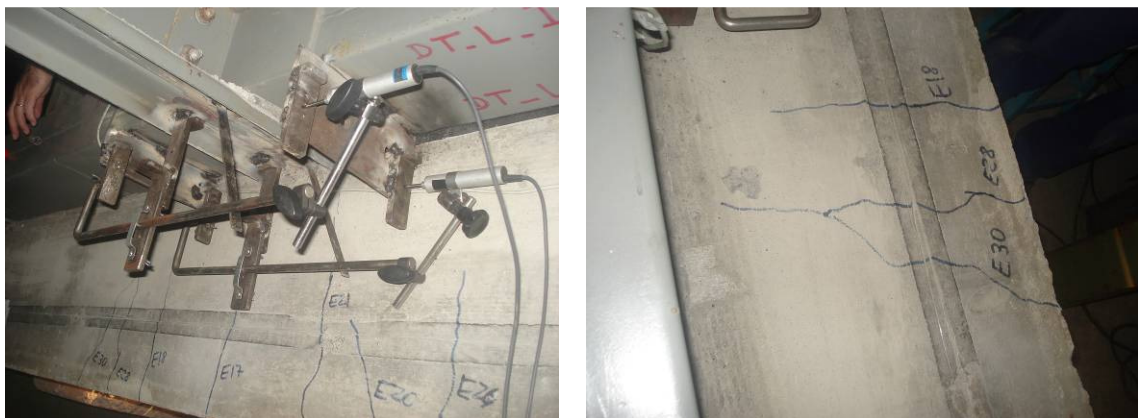
FIG. 4.28 – Fissuração face inferior no modelo 1A.
