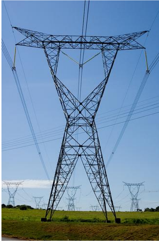
Figura 2. 1: Torre de linha de transmissão aérea.
