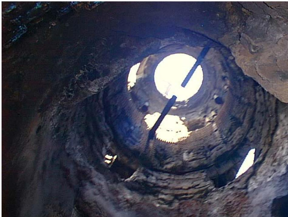
**Figura 9 : Visão interna do topo do alto-forno, podendo ver as crostas de cascão.**
