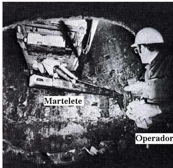
Figura 15: Operador usando uma perfuratriz para arrancar os pedaços de cascão.
