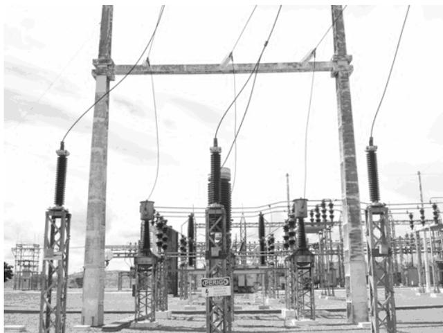
**Figura 35: Pára-raios de 120kV, 10kA fabricante Hitachi.**
