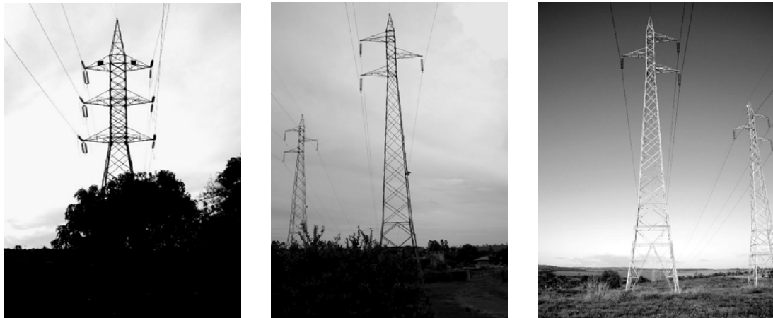
Figura 3.15 - Estruturas típicas da LT sob estudo.
