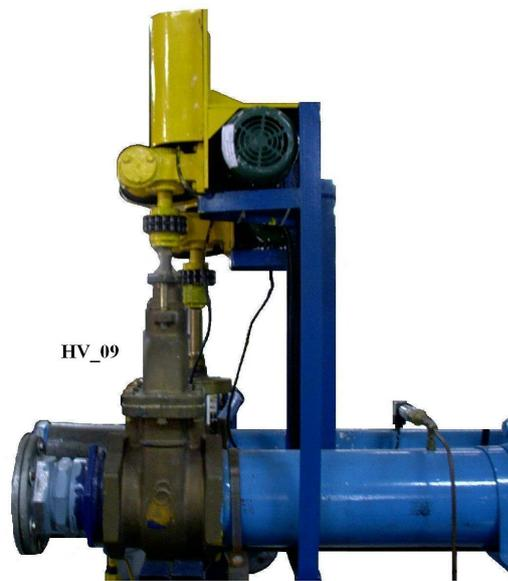
Figura 2.5: Válvula gaveta motorizada.
