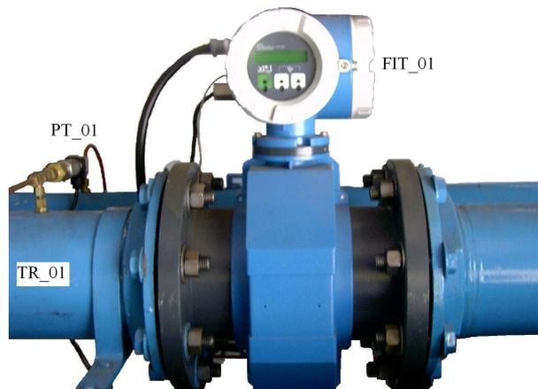
Figura 2.6: Medidor de vazão eletromagnético.
