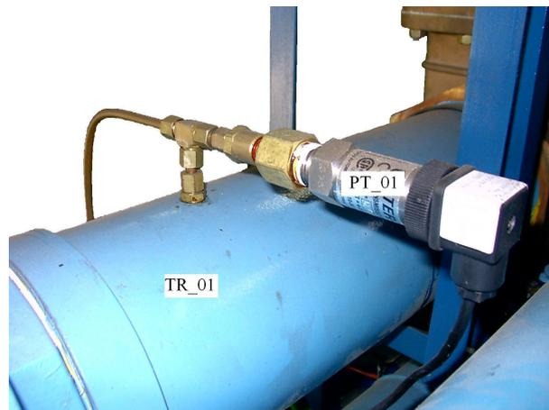
Figura 2.7: Transmissor de pressão de recalque do sistema.
