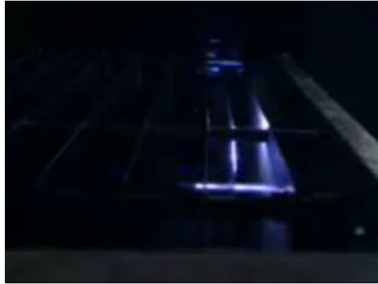
Figura 5.11: Arco-voltaico no espaço interno das placas coletoras.
