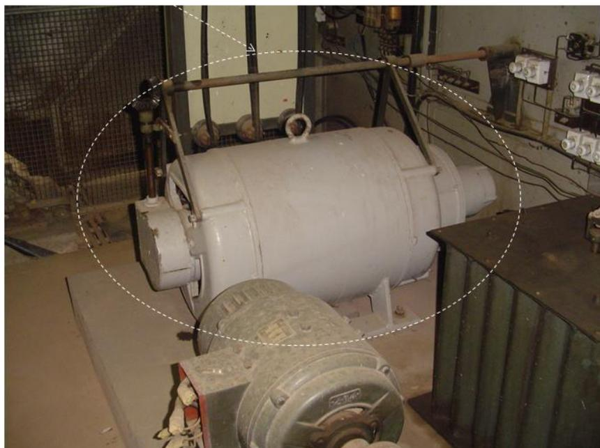
Figura B3 - Detalhe do regulador de tensão de indução trifásico.
