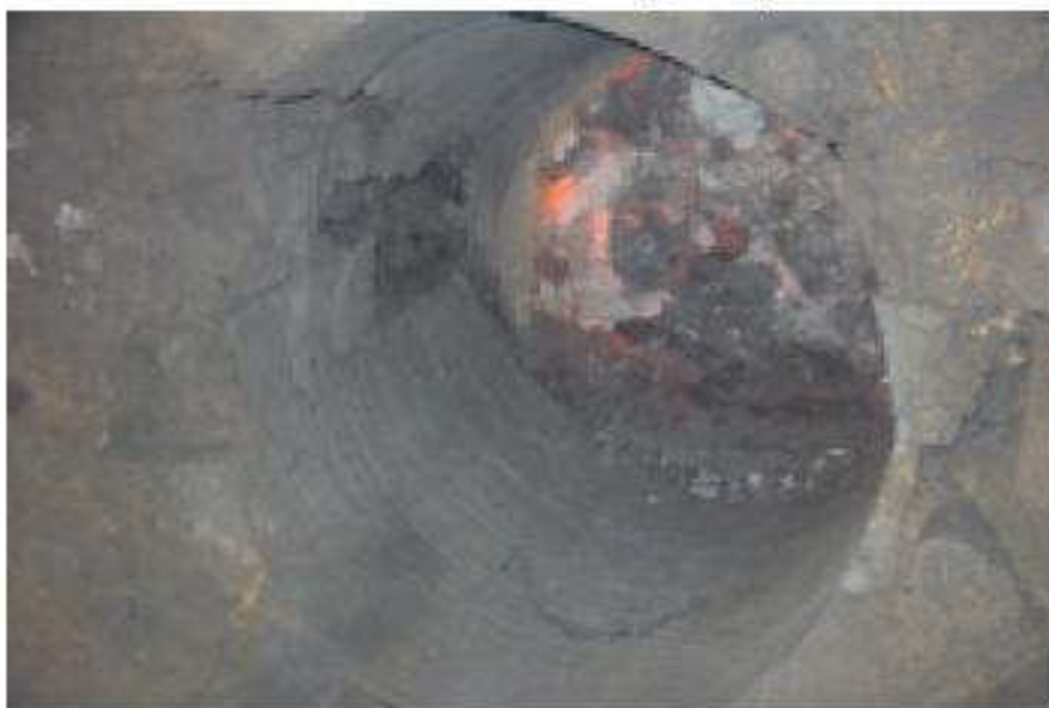
Figura 3.17 Foto da condição do bloco na região do reparo segundo Talaat et al (2005).
