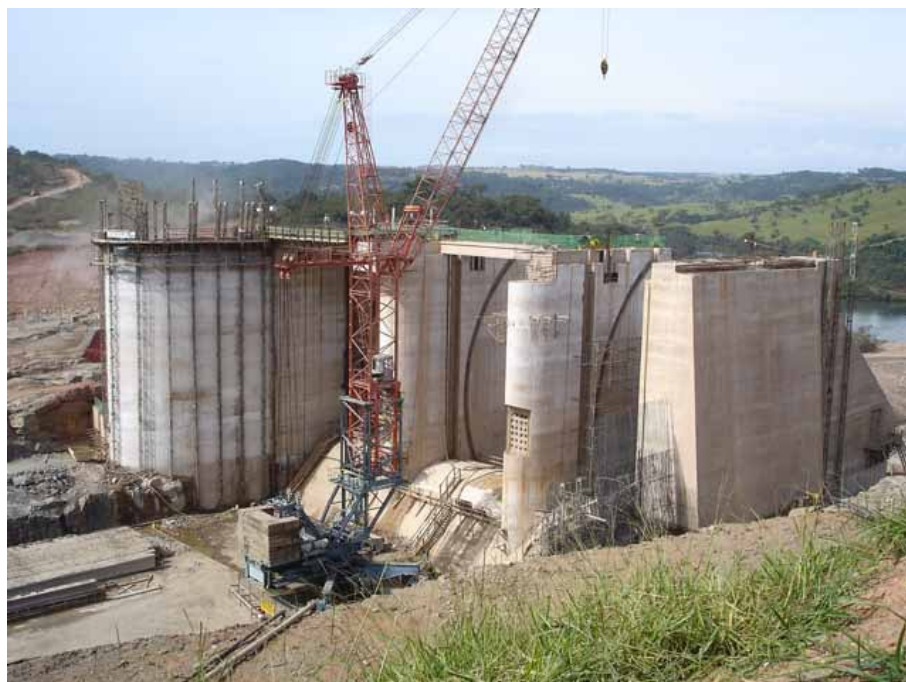
Figura 3.3 – Usina Hidrelétrica Capim Branco I.
