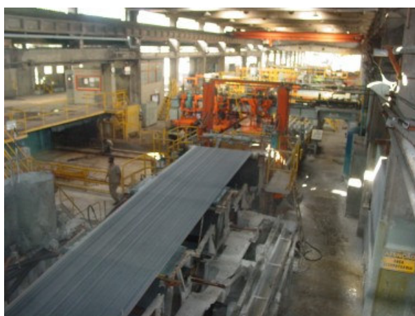
Figura 3.12 – Visão geral de uma linha de produção de telhas de amianto utilizando o processo “Hatschek”.
