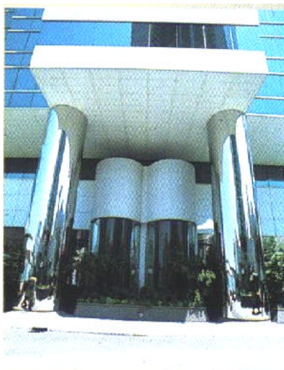
**Figura 6.5. Colunas revestidas com aço inoxidável super espelhado<sup>(24)</sup>**
