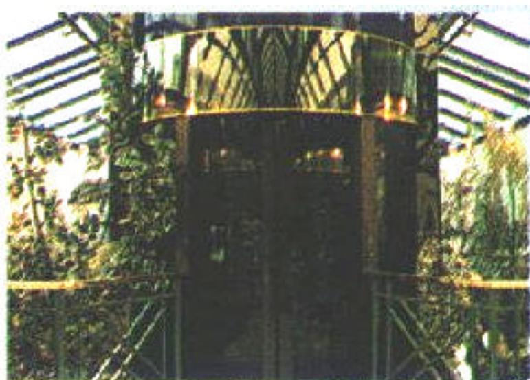
**Figura 6.6. Aço inoxidável dourado super espelhado na entrada de um elevador<sup>(24)</sup>**
