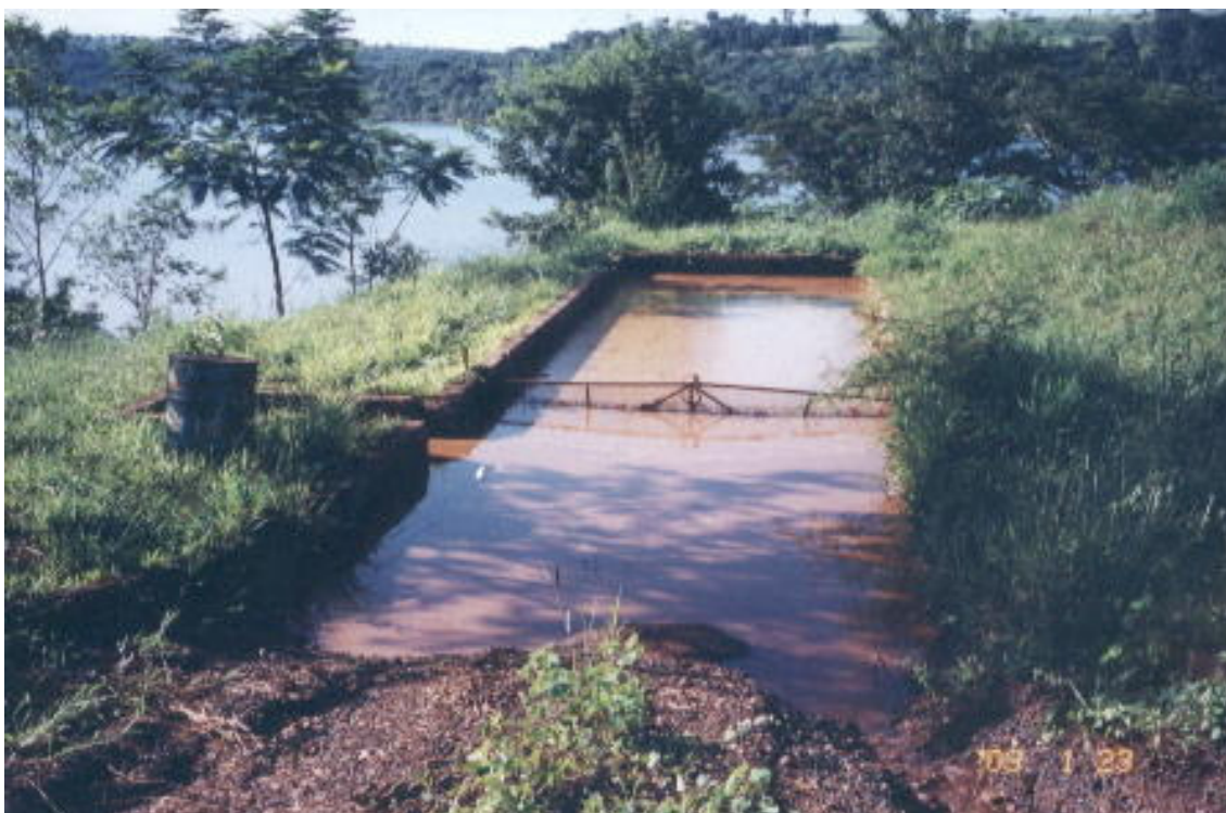
Figura 4.3 - foto 2 – Vista da 2ª bacia de decantação.
