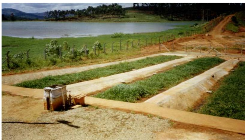
Figura 4.4 – Vista das rampas de escoamento superficial no solo (Fase 1)
