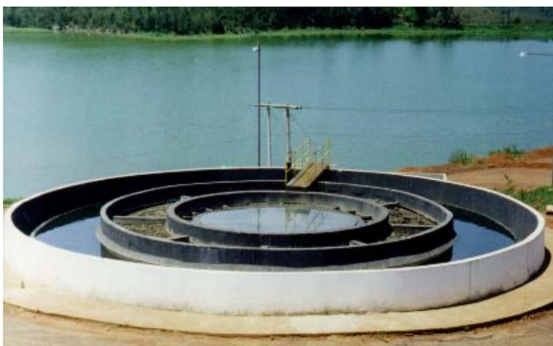
Figura 4.3 – Vista do reator anaeróbio em escala real da ETE Nova Vista (Fase 1)
