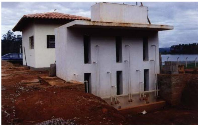
Figura 4.5 – Vista do reator UASB compartimentado em escala piloto (Fase 2)
