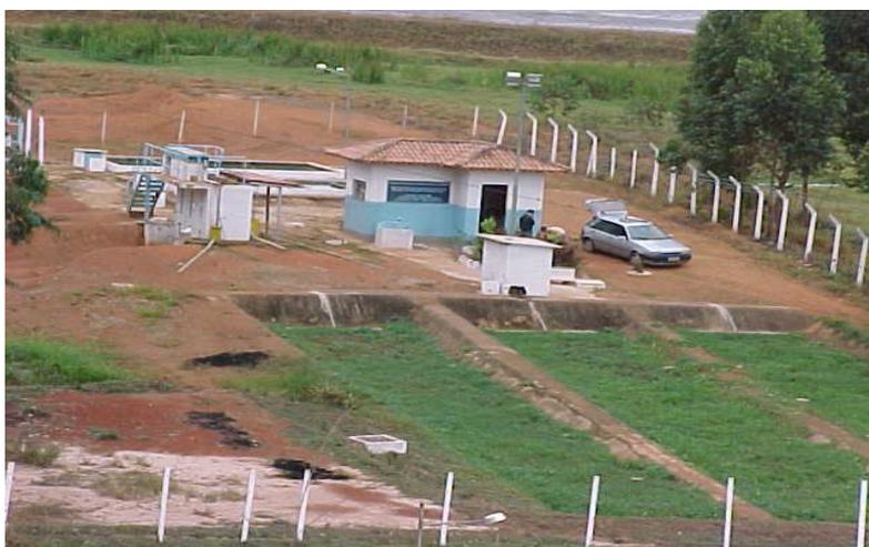
Figura 4.6 – Vista das rampas de escoamento superficial no solo (Fase 2)
