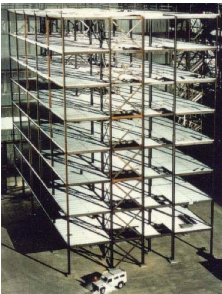
FIGURA 2.9 – Edifício de estrutura mista utilizado nos ensaios em Cardington (fonte: LAWSON, 2001)
