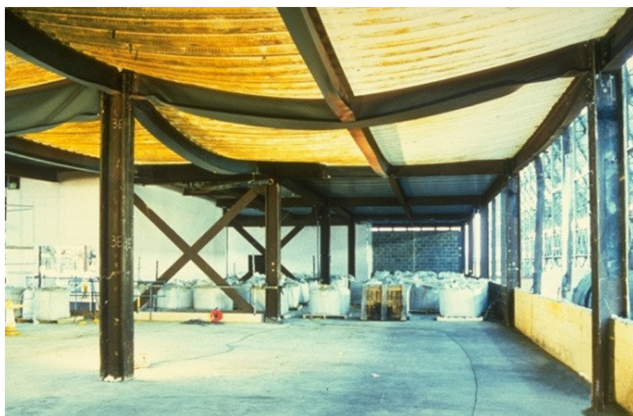
b) O vigeamento sem revestimento térmico mostra-se deformado, porém estável, mesmo tendo atingido temperaturas da ordem de 1100 °C
