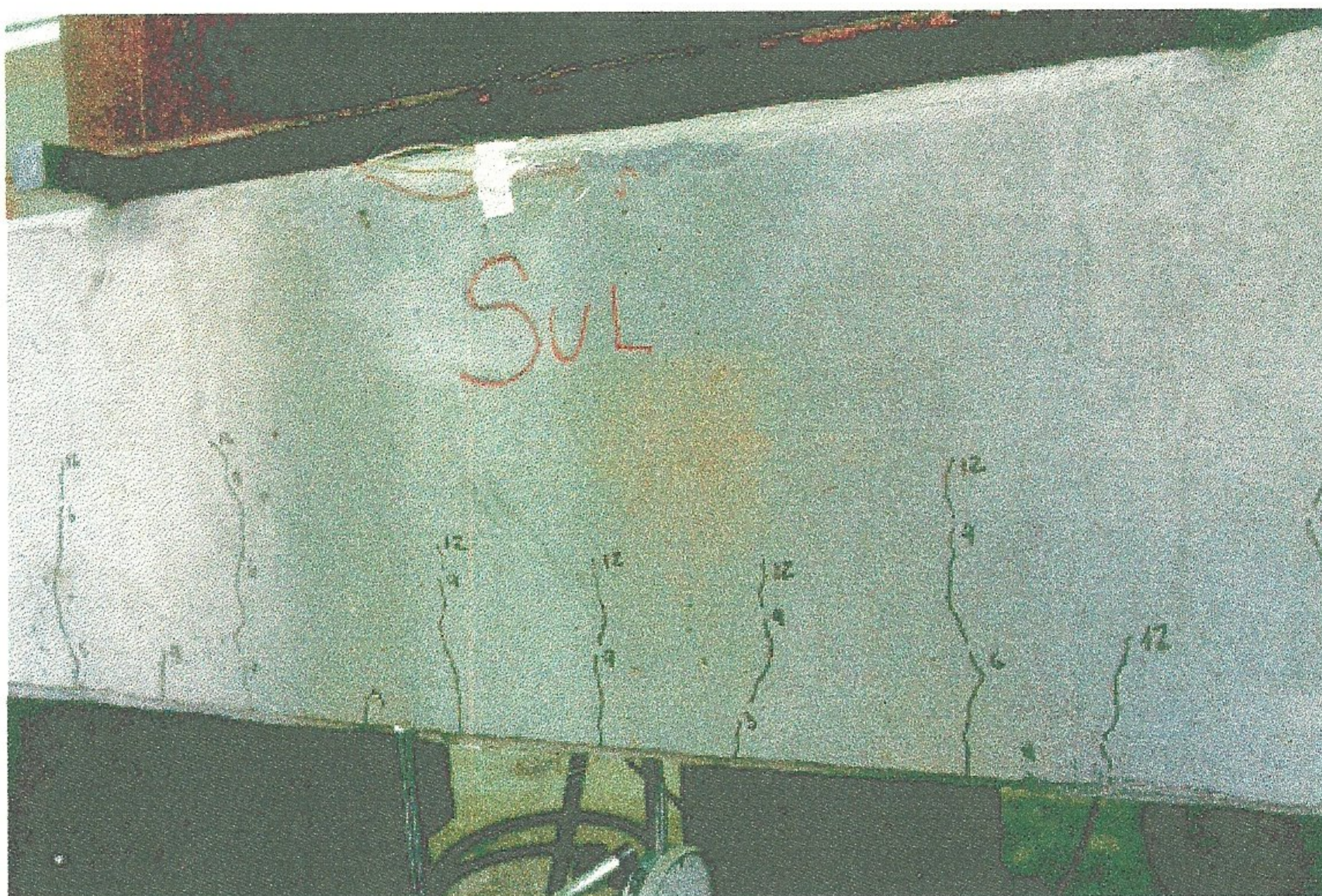
Figura 2.20 - Fissuração típica em viga subarmada solicitada à flexão. [23]
