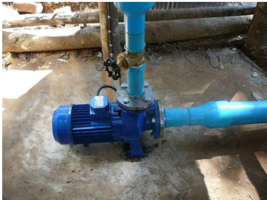
Fig 1. Grupo gerador de Mae Wei. Fonte: BGET (2008).
