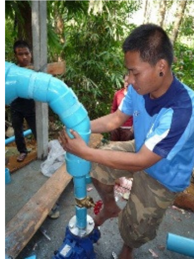
Fig 5. Montagem do sistema de adução.
