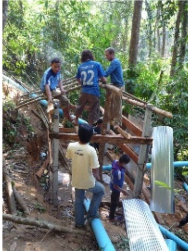
Fig 4. Construção da casa de máquinas.
