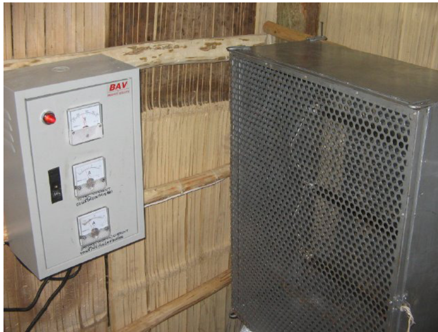
Fig 3. Controle de carga e banco de resistências. Fonte: BGET (2006).
